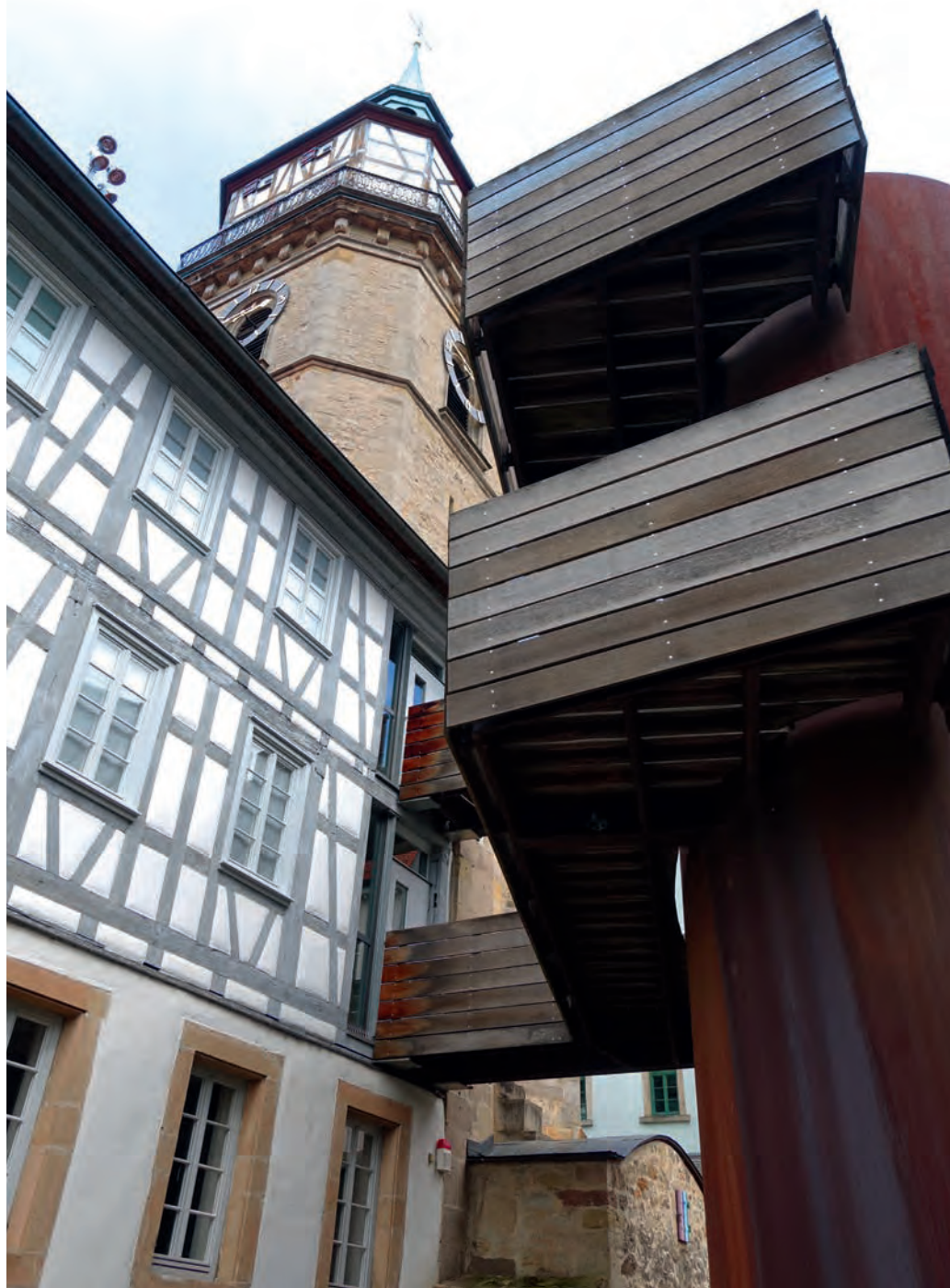
Die 2001 erbaute skulpturale Treppe am historischen Turmschulhaus in Backnang.
