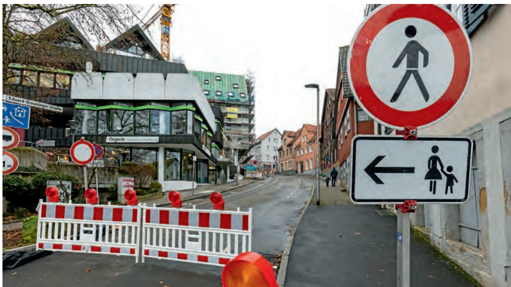
Die Eduard-Breuninger-Straße wird von der Kreissparkasse bis zur Engelkreuzung vollständig saniert und muss deshalb für längere Zeit gesperrt bleiben.
