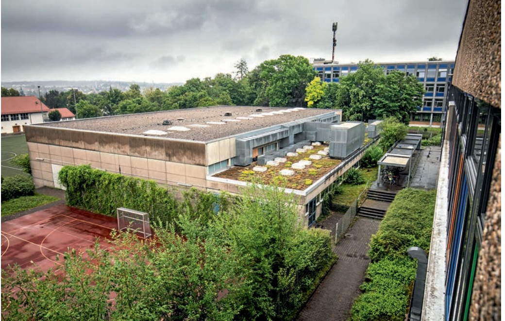
Soll nach 50 Jahren abgerissen und durch einen Neubau ersetzt werden: Die Karl-Euerle-Halle auf der Maubacher Höhe.
