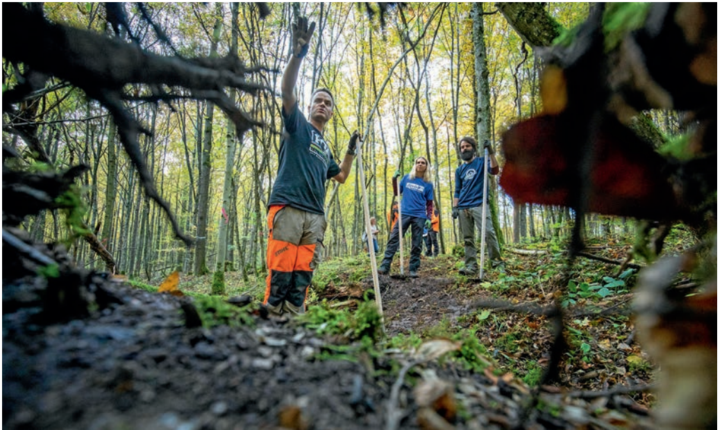
Anlegung eines Mountainbiketrails im Plattenwald.
