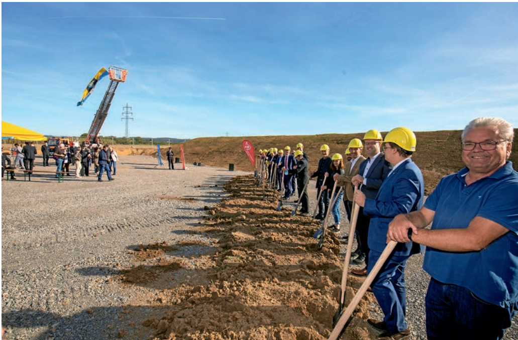
Viel Prominenz beim Spatenstich für das Feuerwehrhaus Backnang-Süd.
