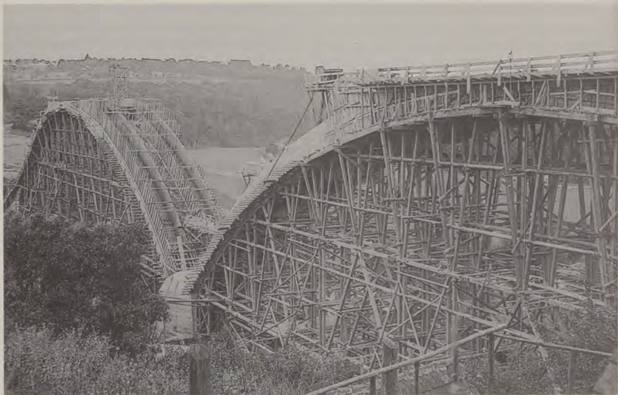
Abb. 14: Das große MurrtaIviadukt im Bau, Juli 1937.
