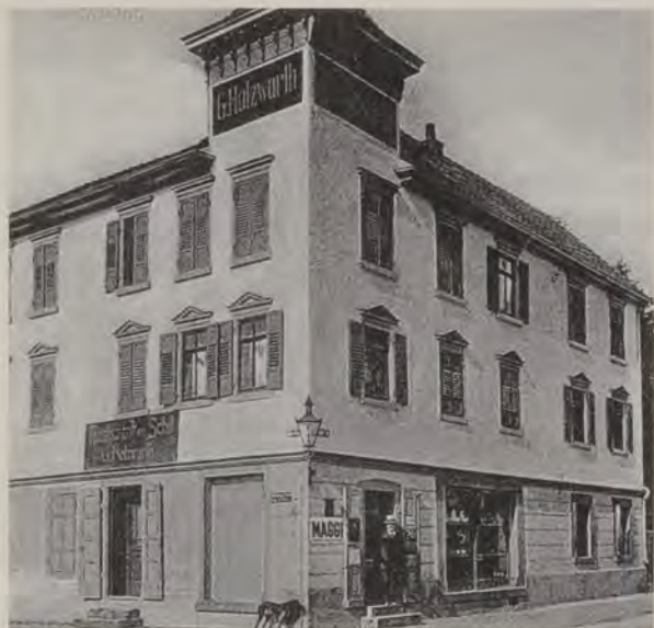
Das frühere Restaurant „Schiff“, Gerberstraße 20, von G. Holzwarth, Ecke Gerberstraße/Wilhelmstraße („Wilhelmseck“ genannt) wird wegen Baufälligkeit abgerissen.
