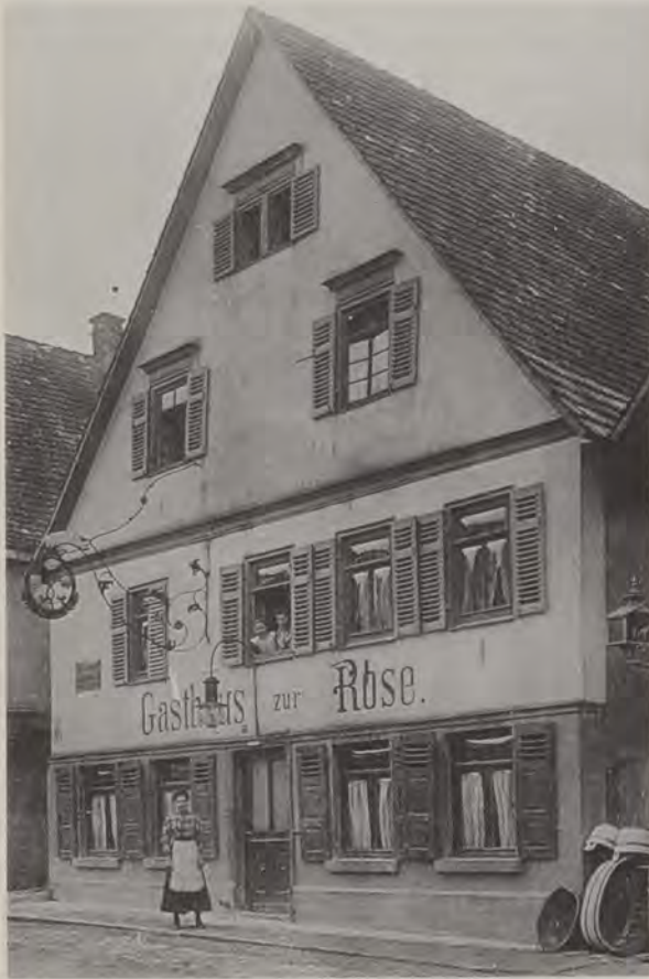
Das Gebäude Stuttgarter Straße 22, Gasthaus zur „Rose“ fällt der Spitzhacke zum Opfer
