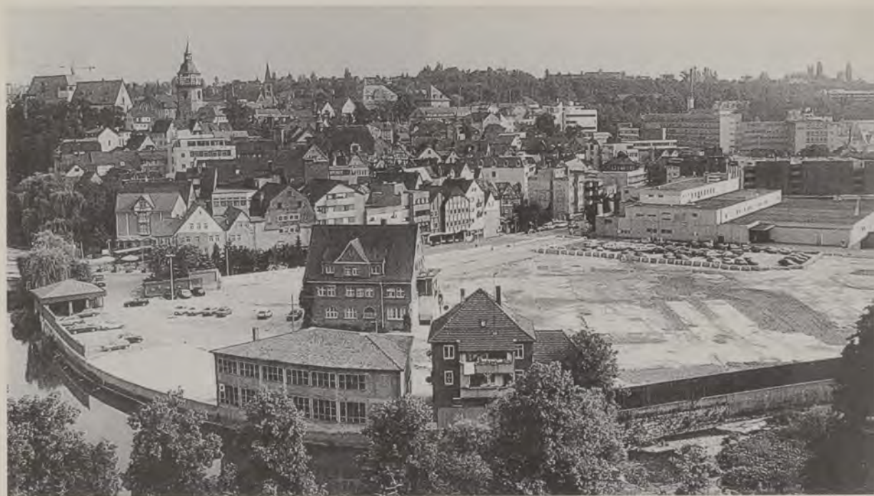
Der Biegel nach dem fast völligen Abbruch der Bauten der ehemaligen Lederfabrik Kaess.
