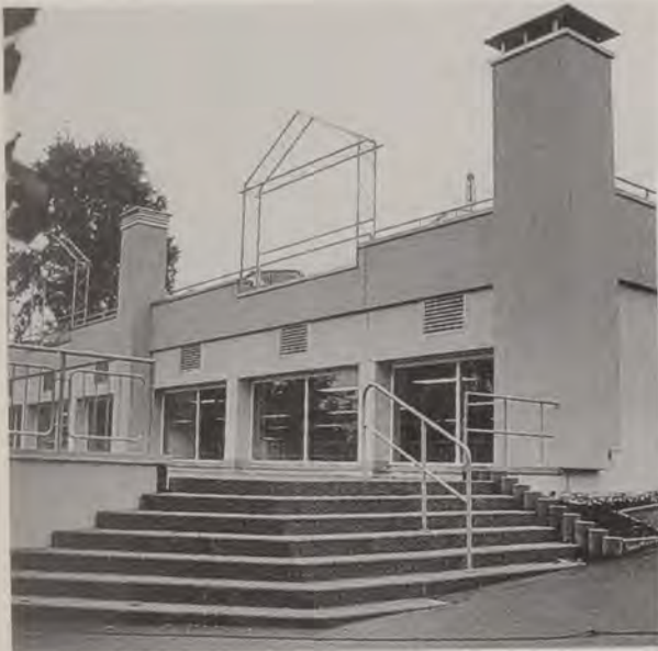
Die neue Turnhalle für die Kinder der Schiller- und Pestalozzischule an der Oberen Bahnhofstraße. Die Dachfläche ist als Parkplatz für 26 Personenwagen ausgebildet.
