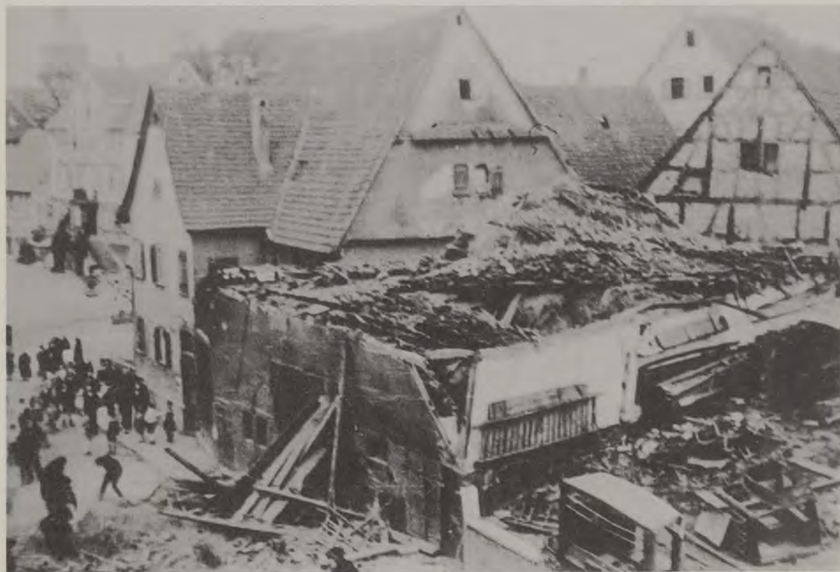
Die Scheuer des Gasthauses zur Sonne, Stuttgarter Straße 25, brach am Sonntag, 3. April 1949, zusammen; Straße und Gehweg waren voll Trümmer. Die Konfirmanden des Jahrgangs 1934/35 befanden sich nach dem Nachmittagsgottesdienst auf dem Heimweg in die obere Vorstadt. Ein Teil war bereits an der „Sonne-Scheuer“ vorbei, ein Teil befand sich noch auf dem Weg zwischen Stiftskirche und „Sonne“. Welch ein Glück: Keiner der Jahrgängerinnen und Jahrgänger wurde verletzt.
