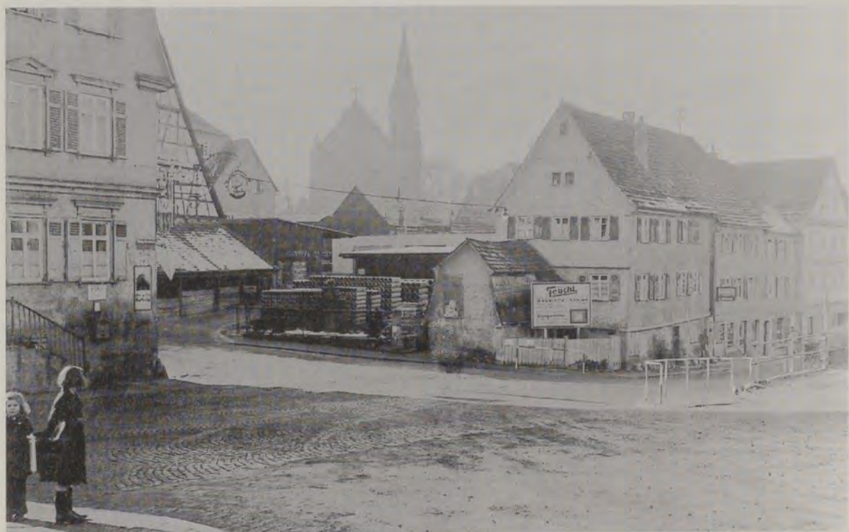
Das einstige Areal der 1927 gegründeten Baustoffgroßhandlung Karl Feucht befand sich an der Einmündung in die Stuttgarter Straße, Obere Bahnhofstraße 2 – 8, gegenüber vom Gasthaus zum „Röble“ (links im Bild). Die Firma Feucht hat heute ihren Sitz in der Maubacher Straße 12 im Gebäude der ehemaligen Ziegelei Wieland, die am 22. Juli 1940 abgebrannt ist.
