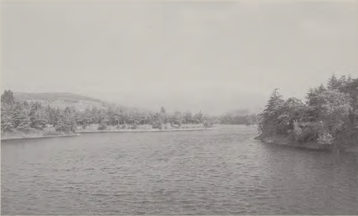
Der Stausee von Ternay, von dem aus Annonay mit Trinkwasser versorgt wird.
