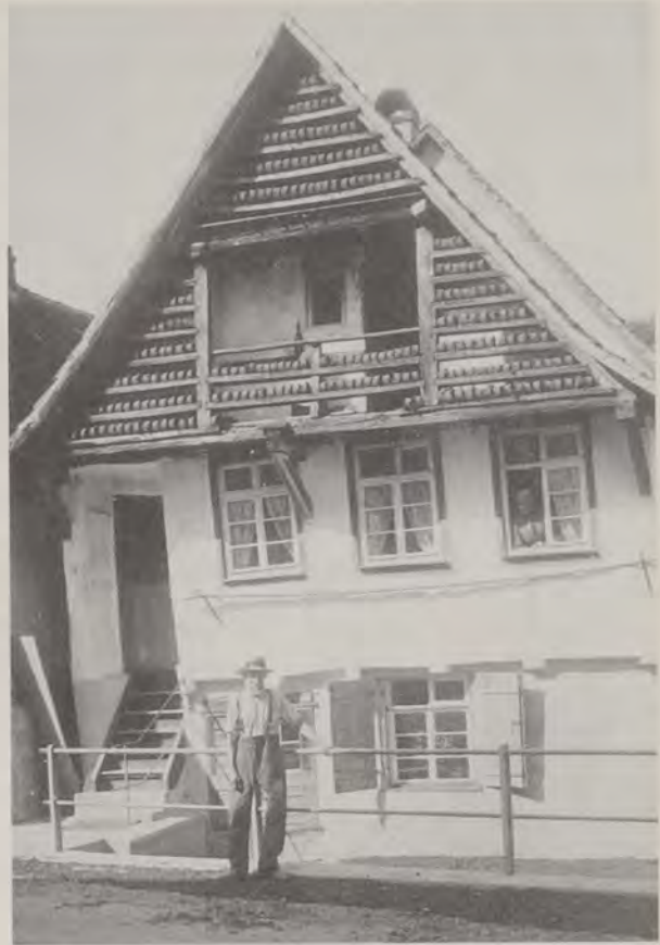
Haus im Biegel mit Lohkäs-Trocknung am Giebel um 1905.
