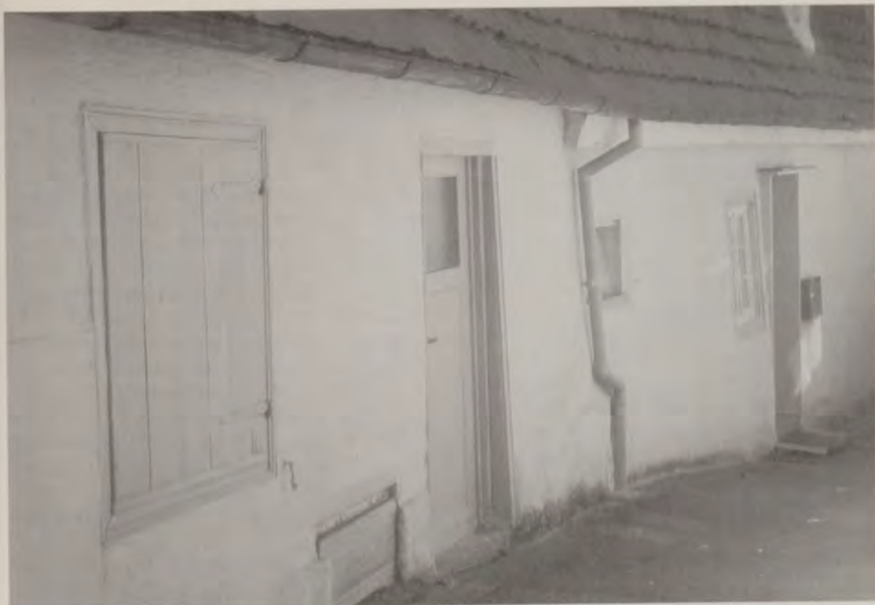
Das Haus Koppenberg 8 – hier die nach Norden gerichtete Eingangsseite – könnte Friedrich Adolff, der seinen Eltern 1837 seine Dachwohnung im Spinnerei-Wohnhaus abtrat, von 1837 bis Ende 1839 als Unterkunft gedient haben. Verkauft wurde es im Januar 1840.
