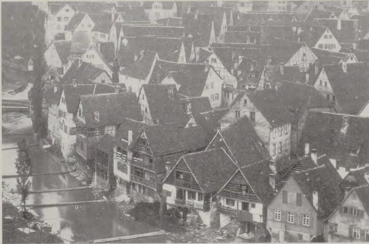
Auf diesem 1892 fotografierten Ausschnitt vom Biegel ist Jakob Breuningers ehemaliges Anwesen zu sehen. Die vierte Anweisung (schwimmender begehbare Steg der Gerber) murraufwärts ist bei seinem Trockenhaus 10a (548) – 1851 vergrößert und dreigeschossig – festgemacht. Rechts daneben, das hohe Haus mit Fachwerkgiebel, ist das Wohnhaus mit Gerberei 10 (247). Dahinter (rechts) das Gasthaus „zum Adler“.
