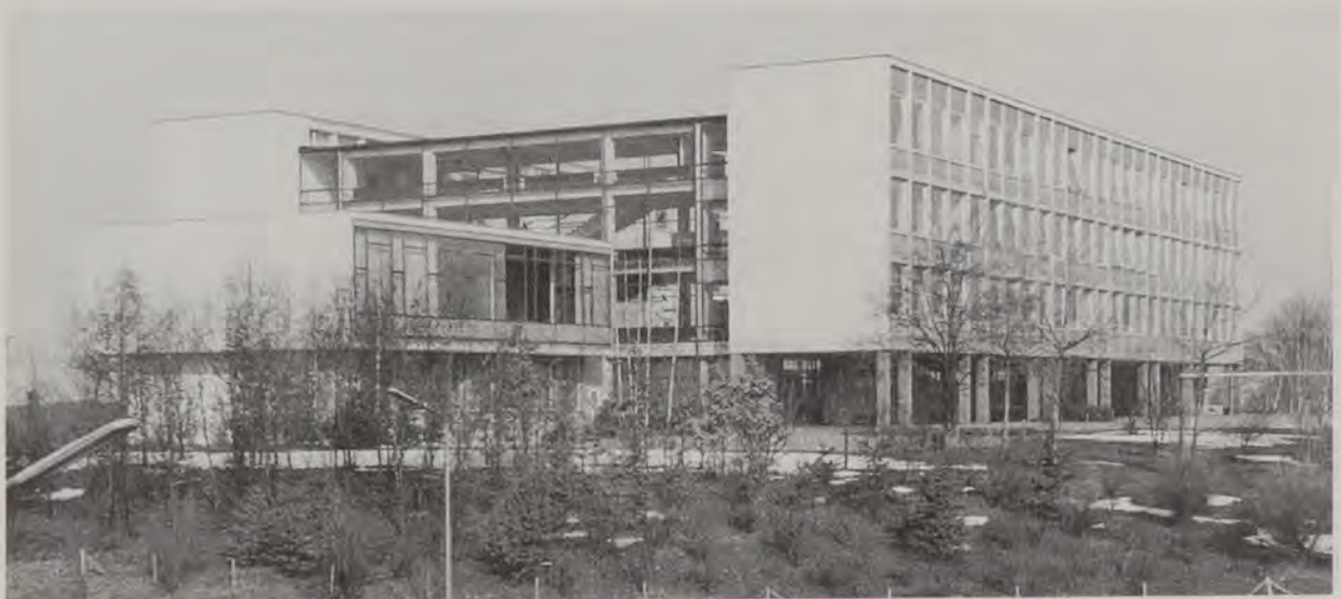
Das Max-Born-Gymnasium unmittelbar nach seiner Fertigstellung.
