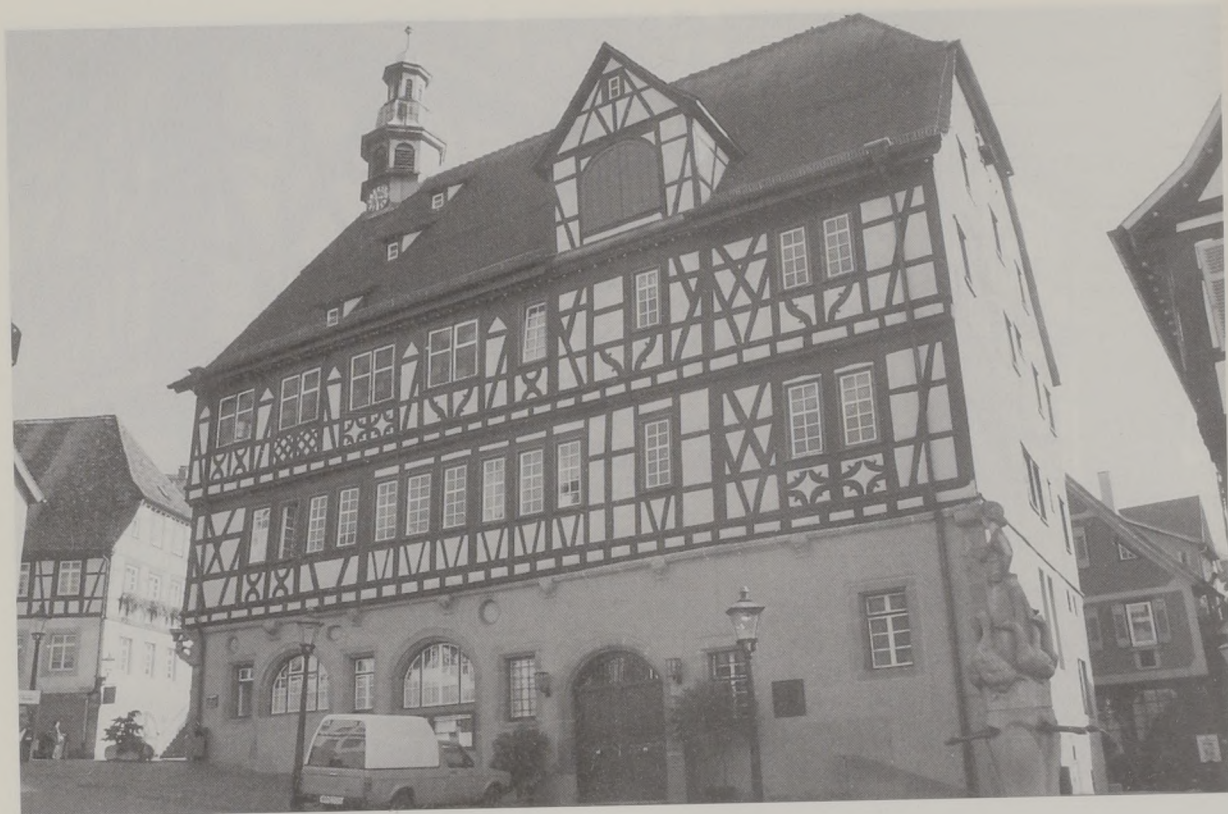
Abb. 11: Ansicht von Nordwesten.
