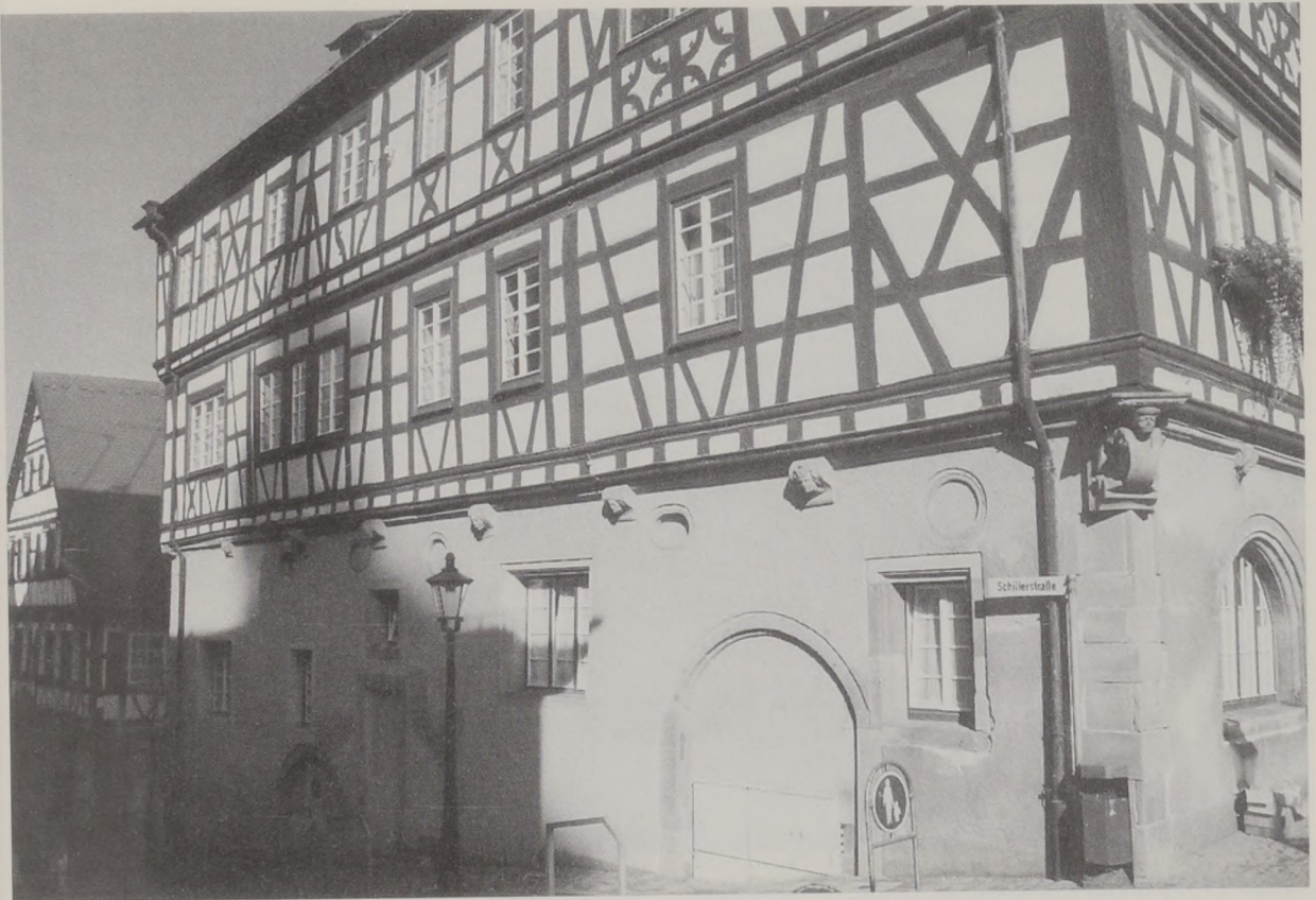
Abb. 10: Ansicht von Südosten.
