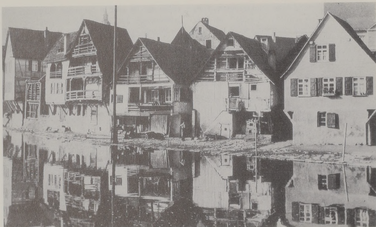
Abb. 15: Der mittlere Teil der Biegel-Häuser am Uferstreifen, Ortsweg 36. Zwischen den beiden rechten Häusern führt der Ortsweg 34 hindurch und man kann gut die vorspringenden Wohngeschosse erkennen, die nachträglich auf die Werkstätten aufgesetzt wurden. Die Häuser links vom OW 34 haben ihre Galerien, die ehemals zum Trocknen des Lohkäs genutzt wurden und, ganz links, auch die Geschosse vorgezogen, so daß sie über den OW 36 überkragen. Der Uferweg ist so aufgeräumt, weil es keine Rotgerber mehr gibt. Das Bild ist um 1928 entstanden.
