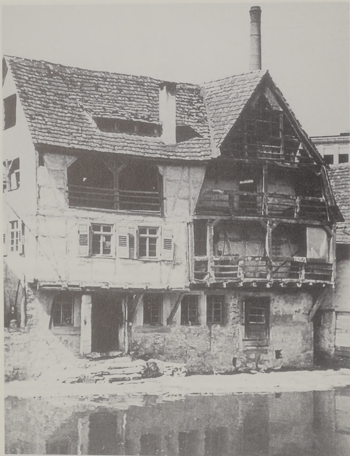
Abb. 21: Die ehemals drei Tuchmachern gehörende eingeschossige Farbwerkstatt 244 (unten links) hatte Friedrich Kaess erworben und 1844 zweigeschossig überbauen und mit dem 1840 von seinem Vater geerbten Trockenhaus 243 (rechts) verbinden lassen. Neben zwei kleinen Gerberwerkstätten und einer Zurichstube besaß es nur noch Trockenräume. Von der Murrseite ist ihm kaum anzusehen, daß sein Grundriß nur etwa 60 Quadratmeter beinhaltet und daß es außen nur einen einzigen rechten Winkel besitzt. Foto von etwa 1930.
