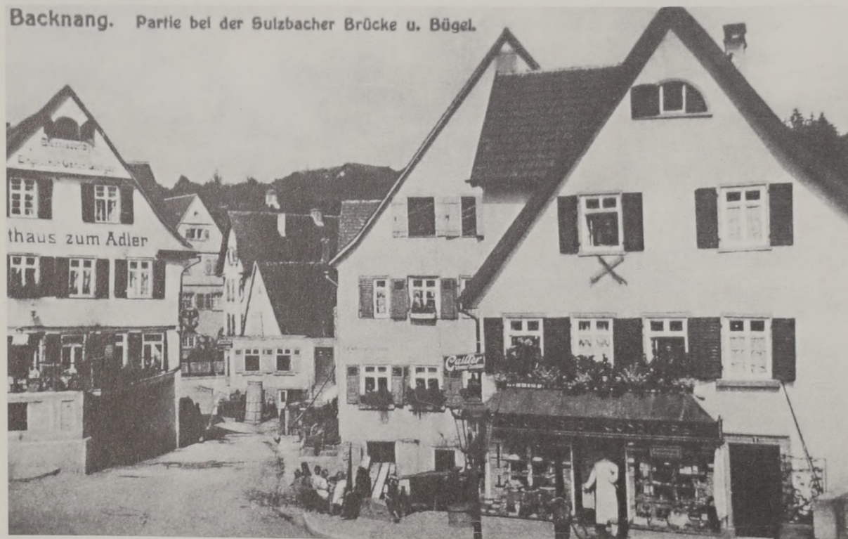
Abb. 29: Blick von der Sulzbacher Straße in den Biegel. Das Haus Im Biegel 12 ist schon zur Hälfte abgebrochen. Rechts die Conditorei Gebhardt, Sulzbacher Straße 1, im Jahr 1913.
