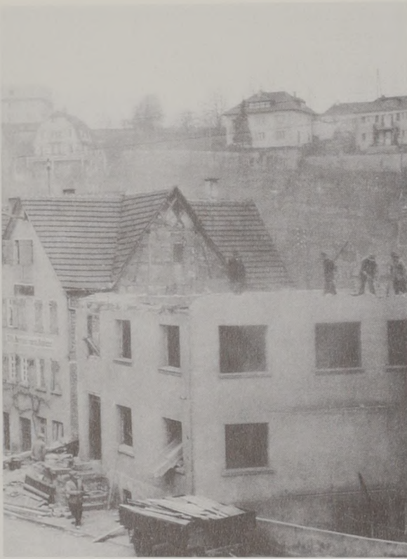
Abb. 34: Das zwischen der Konditorei Gebhardt und der ehemaligen Küblerei Rommel gelegene Haus Im Biegel Nr. 2 beim Abbruch im Januar 1954. Diese Lücke wurde bis 1977 als Parkplatz genutzt.
