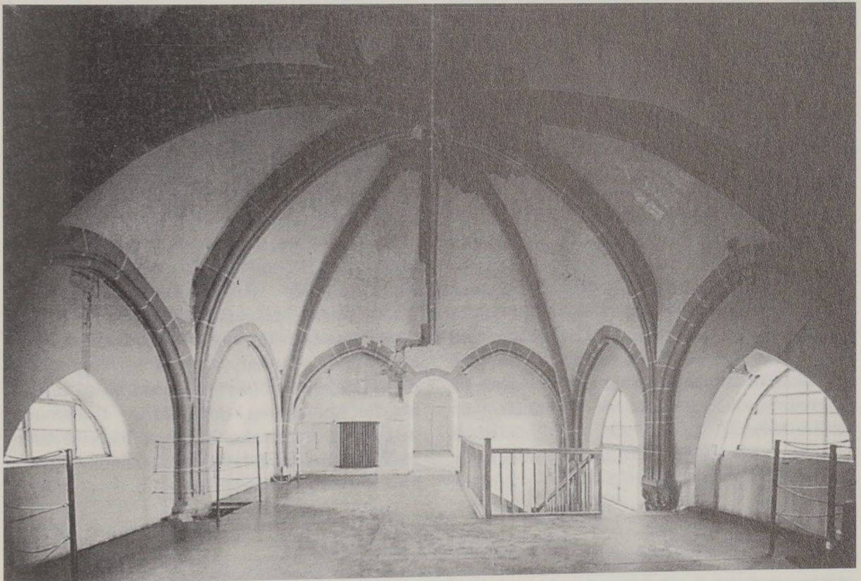
Abb. 24: Das neunstrahlige Rippengewölbe des gotischen Chors, nach Westen.
