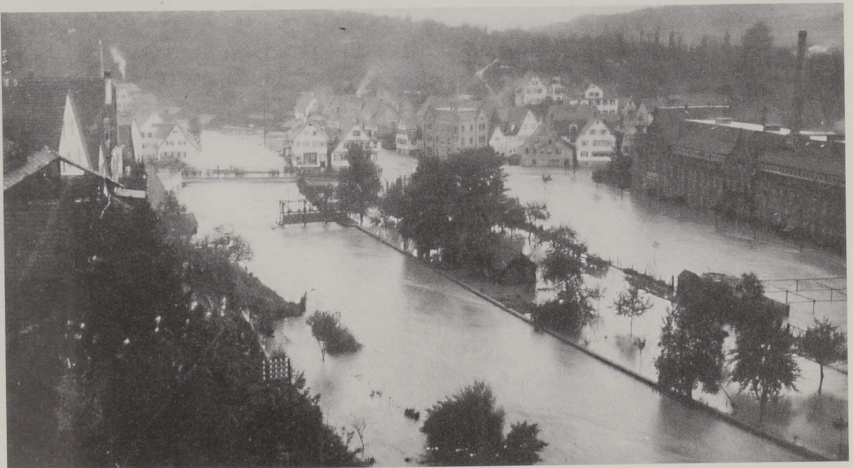
Abb. 68: Das Hochwasser vom 9. September 1912 mit einem Anstieg von mehr als 2,00 m zeigt die Grenzen von Regulierungsarbeiten im Bereich der Sulzbacher Brücke auf.
