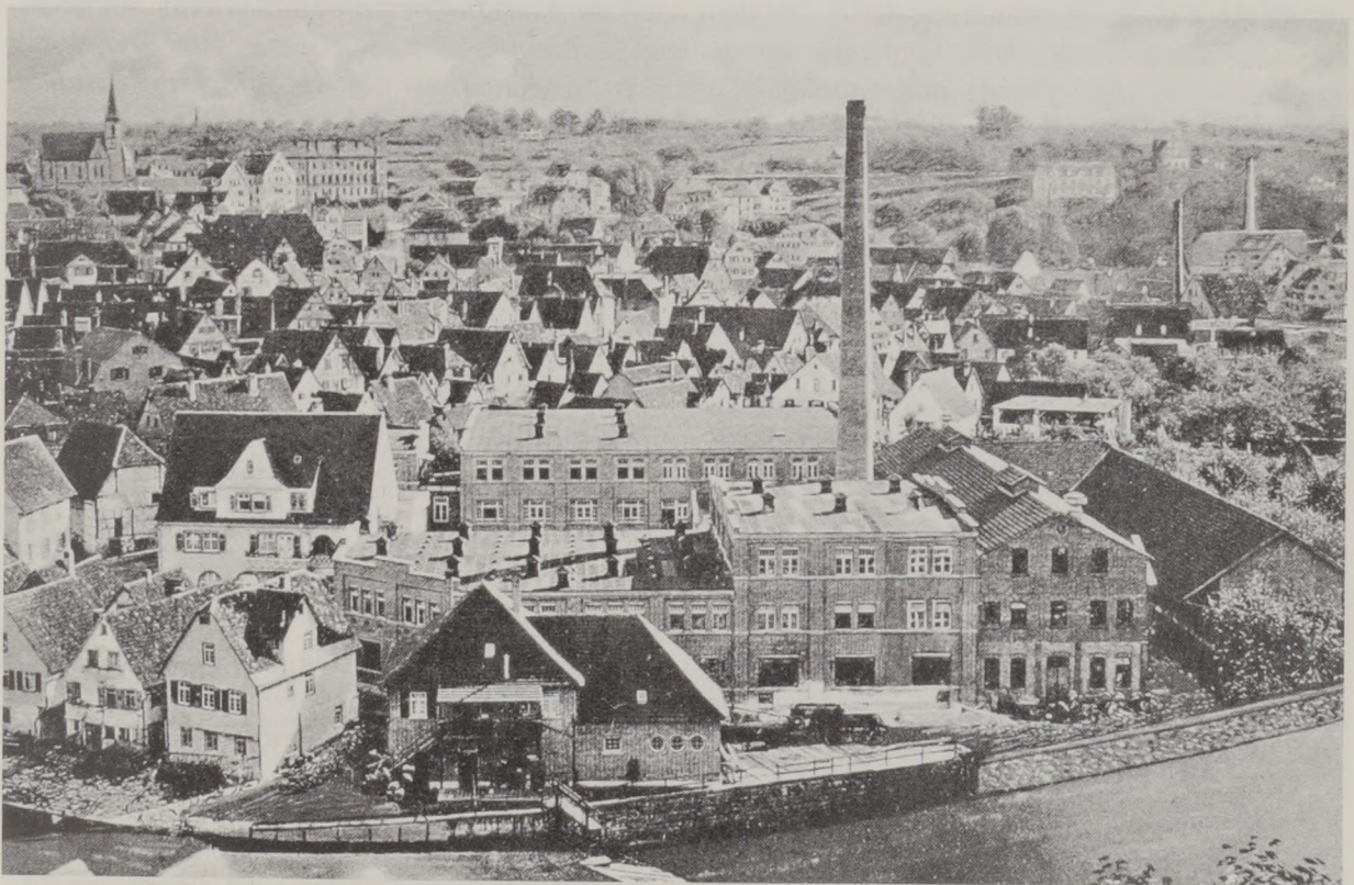
Abb. 57: Das Foto aus dem Jahr 1912 zeigt die in vier Jahren entstandene neue Anlage der Lederfabrik Carl Kaess im Biegel. Vorne der erst 1910 entstandene Pferdestall mit Wagenremise und Kutcherwohnung. Die prall gefüllte Murr unterhalb des Wehrs mit der akkuraten Uferböschung ist allerdings ein Werk des Retuscheurs, der auch einen Schornstein, der von der damaligen Badstraße aus in das Bild ragte, hatte verschwinden lassen. (Ausschnitt von einer Postkarten-Stadtansicht).
