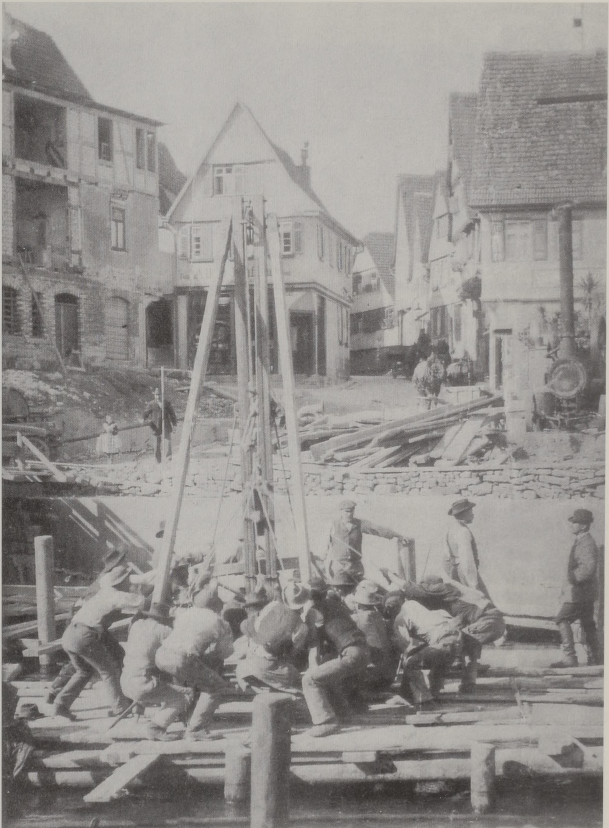
Abb. 67: Mitte August 1904: Gearbeitet wird am Mittelpfeiler der neuen Brücke. Bildmitte: Blick in die Uhlandstraße mit dem Geschäft A. Isenflamm (links). Daneben wird am Haus des Seifensieders Stolpp die vom Haus Stierle befreite Wand gerichtet. Die Dampflokomobile (rechts) treibt eine Pumpe an, mit deren Hilfe Arbeitsgruben vom Wasser freigehalten werden.
