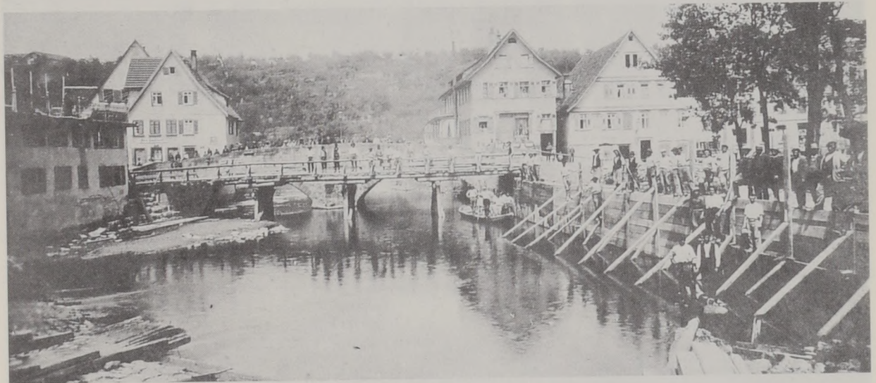
Abb. 65: Ende Juni 1904 stand die hölzerne Notbrücke und die Ufermauer war betoniert.
