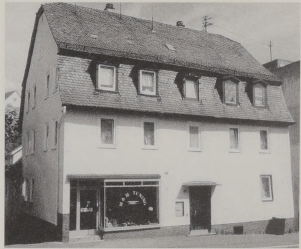
Abb. 18: Das frühere Gerbereigebäude Wilh. Ehmann, Sulzbacher Straße 44, im Jahr 2001. Hinten links der Anbau von 1885.
