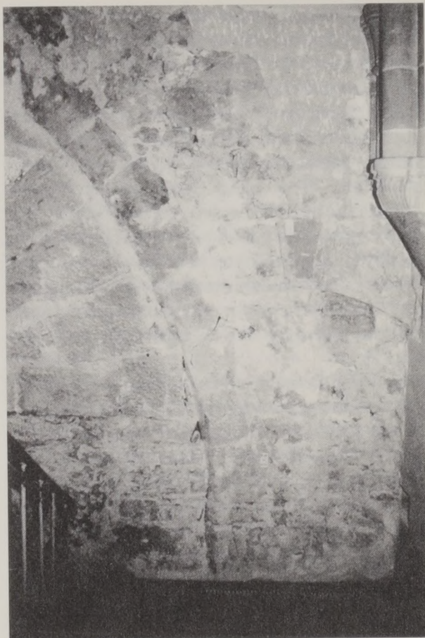
Abb. 4: Westwand, ehemalige Chorwand/Anschluss zur Nordwand – der Segmentbogen einer ehemaligen Lettneranlage bricht nach Süden hinter dem Schlussstein ab; an der Abbruchkante der ehemaligen Chorwand ist deutlich das nachträgliche Einfügen eines Chorbogens ablesbar; dieser Chorbogen ist beim Schulhausneubau mit zweitverwendeten Quadern zugesetzt worden.
