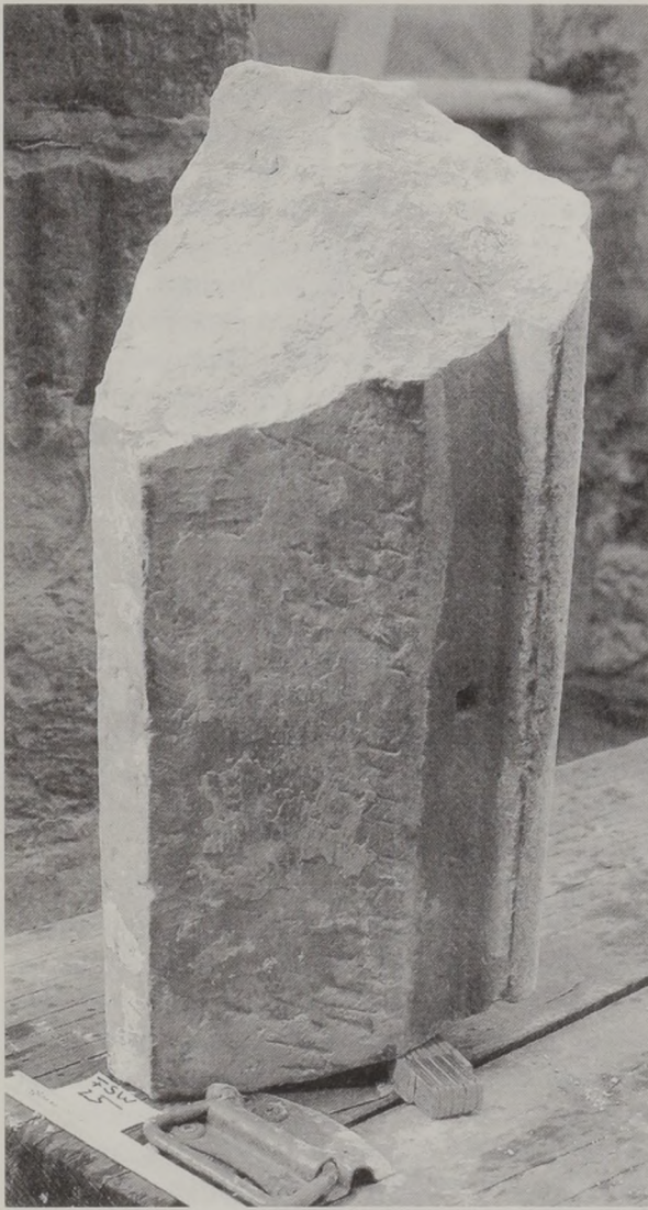
Abb. 6: FSW 25 – Stabwerkteile, 13. Jh., Schilfsandstein, an der Schmalseite vor dem Fensteranschlag Vertiefungen für Windeisen, an einer Seite viereckige Aussparung (1,5 x 1,5 cm, Tiefe mind. 2 cm), an der anderen Seite Vertiefung jeweils mit schleifender Rille zum Einschieben des Eisens.
