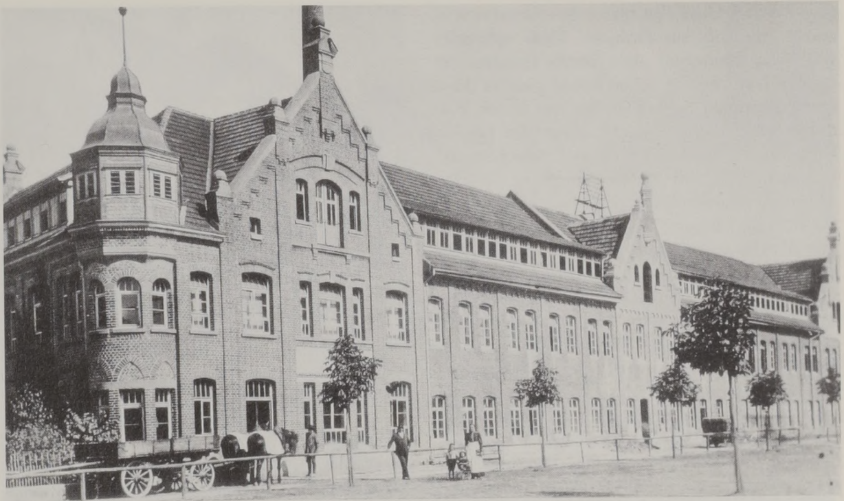
Abb. 24: Der Zustand der Fabrikbauten an der Bleichwiese nach Fertigstellung des Dachausbaus mit aufgesetzten Zwerchgiebeln durch Baumeister Fritz Müller. Foto von 1911.
