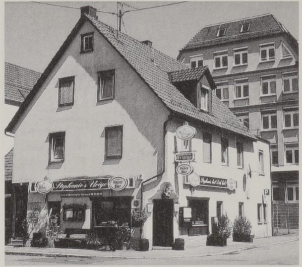
Abb. 39: Das Gebäude Karlstraße 12 ist als letztes der von Eckstein und Esenwein um 1885 errichteten Wohn- und Gerbereigebäude noch erhalten geblieben. Mit Anbau versehen wird es heute als Gaststätte genutzt.
