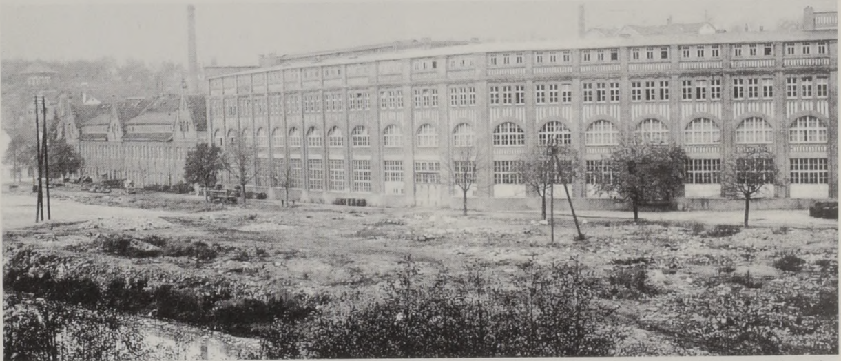
Abb. 30: Foto der Bleichwiesen-Ansicht um 1927. Das nachträglich auf dem modernen Gebäude- teil aufgesetzte Dachgeschoss kam erst nach 1918 zur Ausführung. 1939 wurde es abgebrochen und in der Höhe den neuen Bauten von 1937/38 angeglichen.
