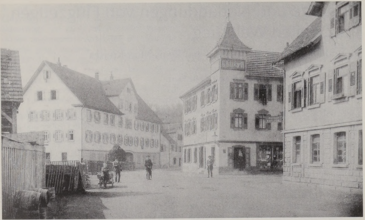
Abb. 47: Die Gerberstraße mit der Abzweigung Wilhelmstraße im Jahr 1902. Von links: Das Doppelhaus 27/29, das Wohn- und Bürogebäude Friedrich Häuser, das Wilhelmseck von G. Holzwarth und die Lederfabrik Gebrüder Eckstein.
