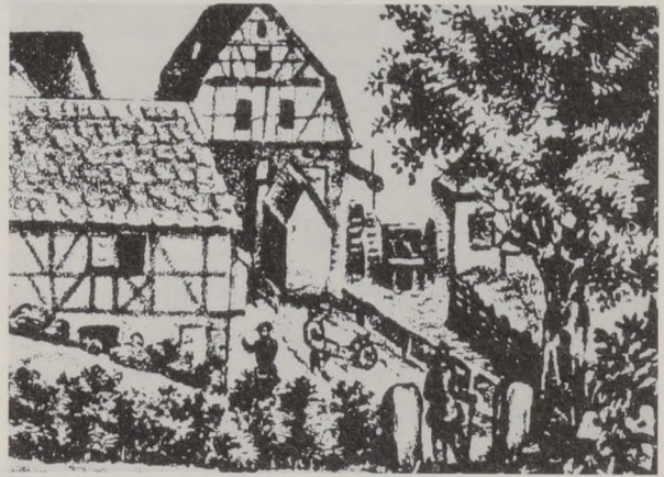
Abb. 56: Diese um 1840 entstandene Lithografie von Friedrich Angerbauer zeigt die in der Walke stehende Loh- und Sägmühle mit dem Mansarddach und rechts davon einen Teil der Walke. Dazwischen befinden sich die Mühlräder mit dem mit Weidengeflecht abgesicherten Mühlkanal, dessen Wasser zur Ölmühle fließt.
