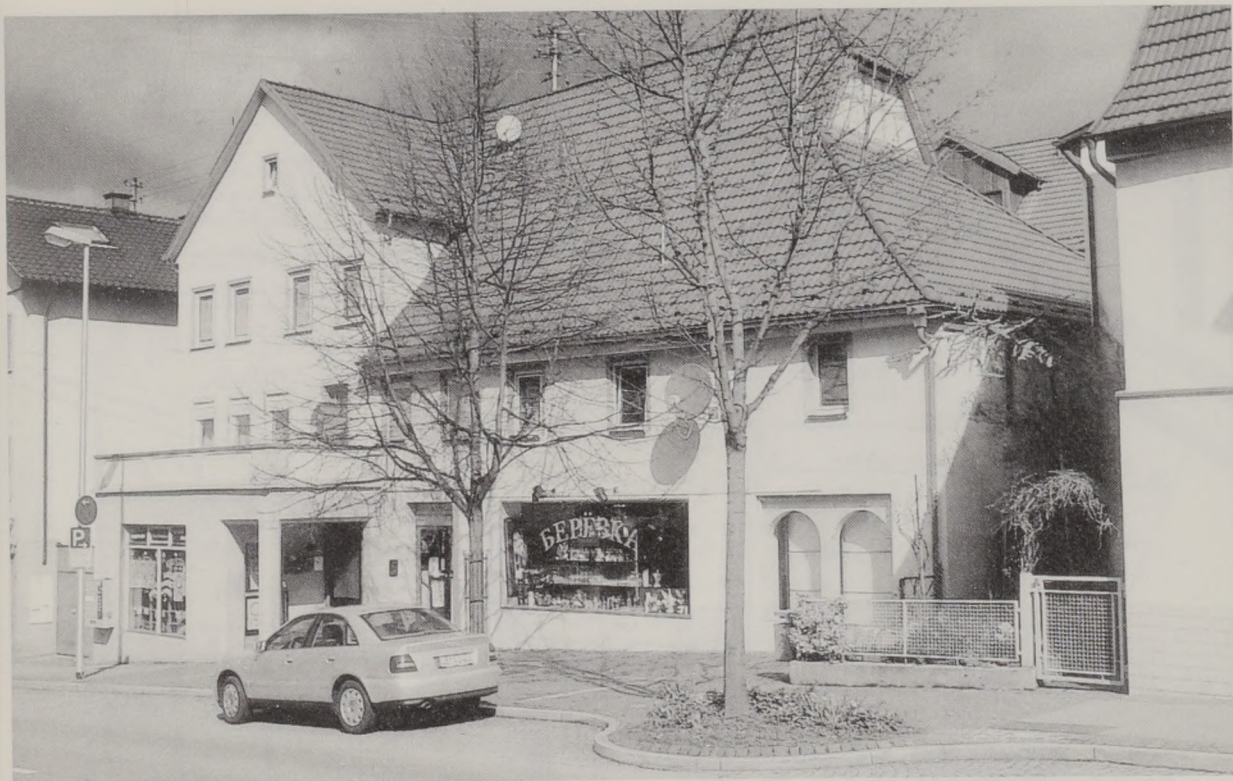
Abb. 2: Zustand des landwirtschaftlich nicht mehr genutzten Gebäudes Stuttgarter Straße 41 im Jahr 2004. Das Wohnhaus wurde um einen Vor- und einen Zwerchbau sowie den massiv ausgeführten ehemaligen Scheuer- und Wagenhütten-Anteil erweitert.
