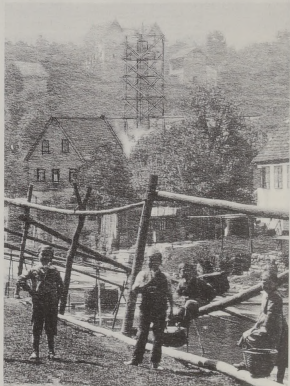
Abb. 27: Auf diesem um 1893 am Kalten Wasser entstandenen Foto ist zufällig der Bau des neuen Schornsteins für die vergrößerte Heizungsanlage der Lederfabrik Friedrich Häuser festgehalten worden. Zu erkennen ist auch, dass der Steilhang an der Murr noch frei ist von großen Bäumen.
