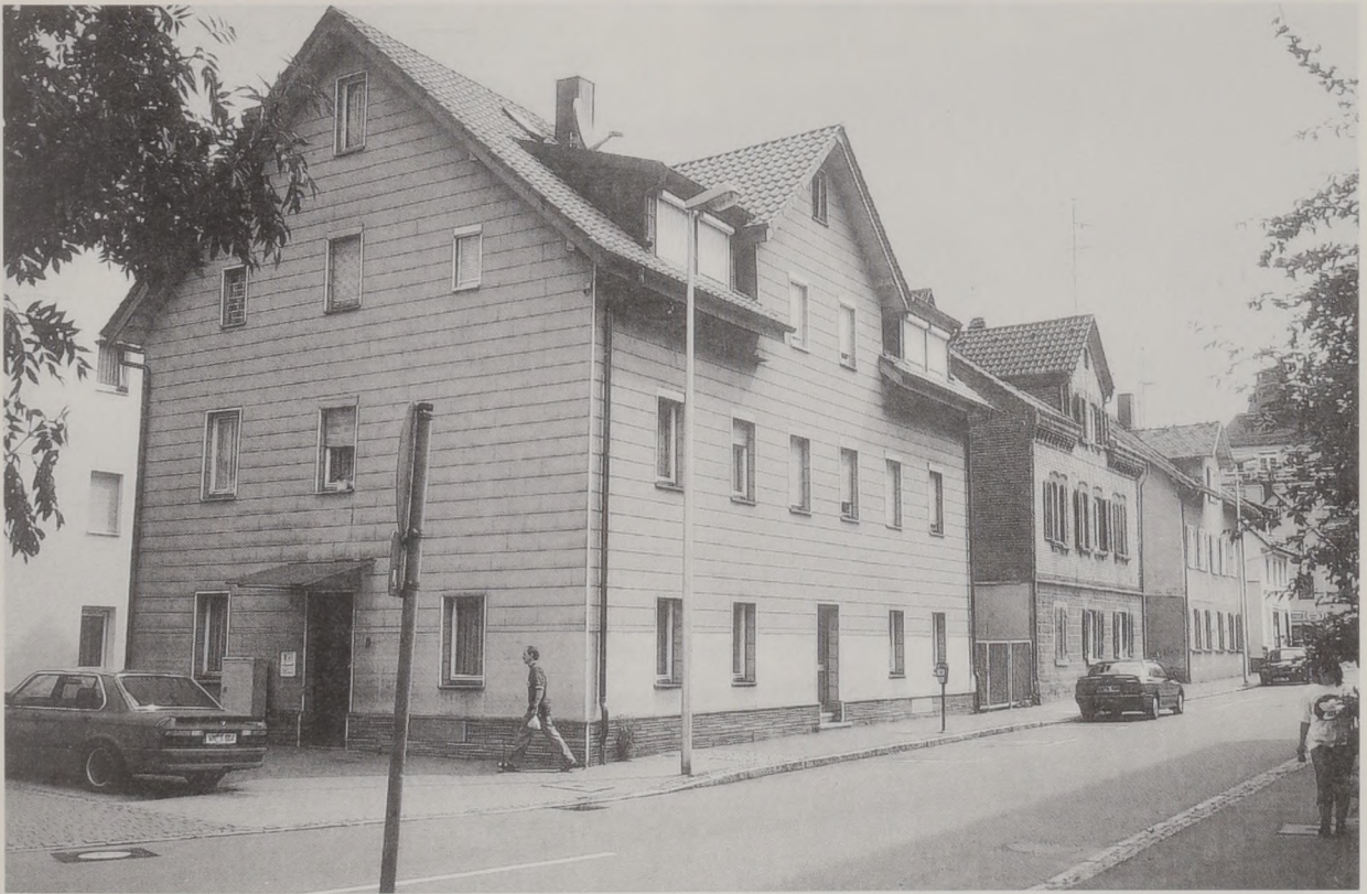
Abb. 37: Das an der Ecke Friedrichstraße 10/Gerberstraße stehende ehemalige Wohn- und Gerbereigebäude (mit einem Anbau) hatte Friedrich Kaess jun. 1881 erworben. Foto von 2005.
