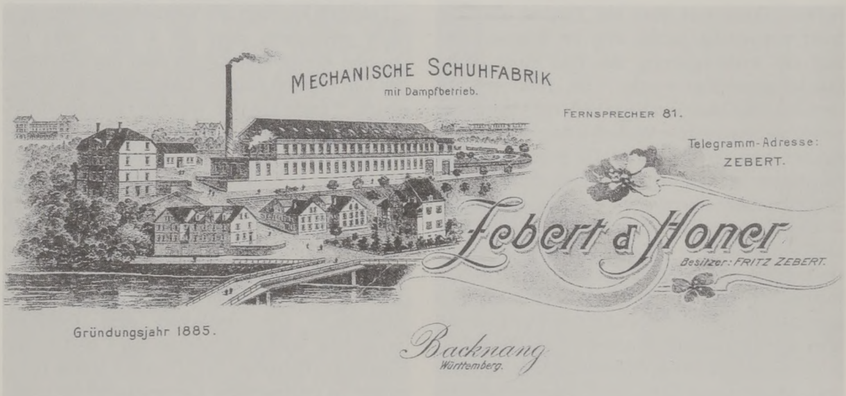
Abb. 50: Auf der Visitenkarte der Firma Zebert & Honer ist auch die von Gottlob Häuser begonnene Ansiedlung am Etwiesenberg zu sehen. Stand 1910.
