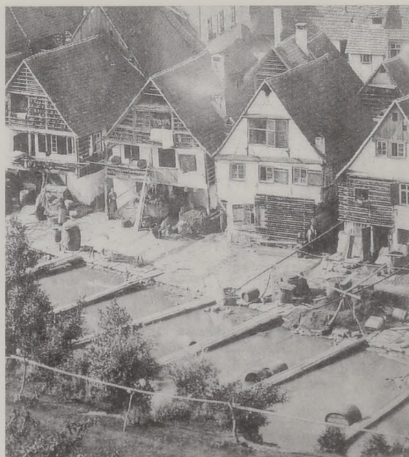
Abb. 59: Der Ausschnitt vom Biegel um 1874 zeigt, dass Anweisungen keine Brücken ersetzen können.
