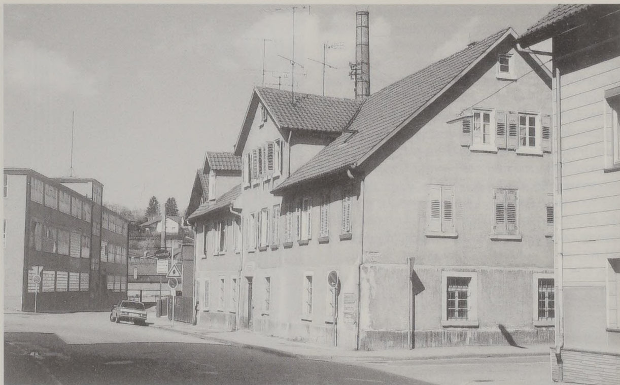
Abb. 24: Das 1873 von Zimmermeister Gottlob Wilhelm an Jakob Häuser übergebene Doppelhaus 632 (Gerberstraße 52/54). Im Erdgeschoss befanden sich die Gerbereien. Foto von etwa 1980.
