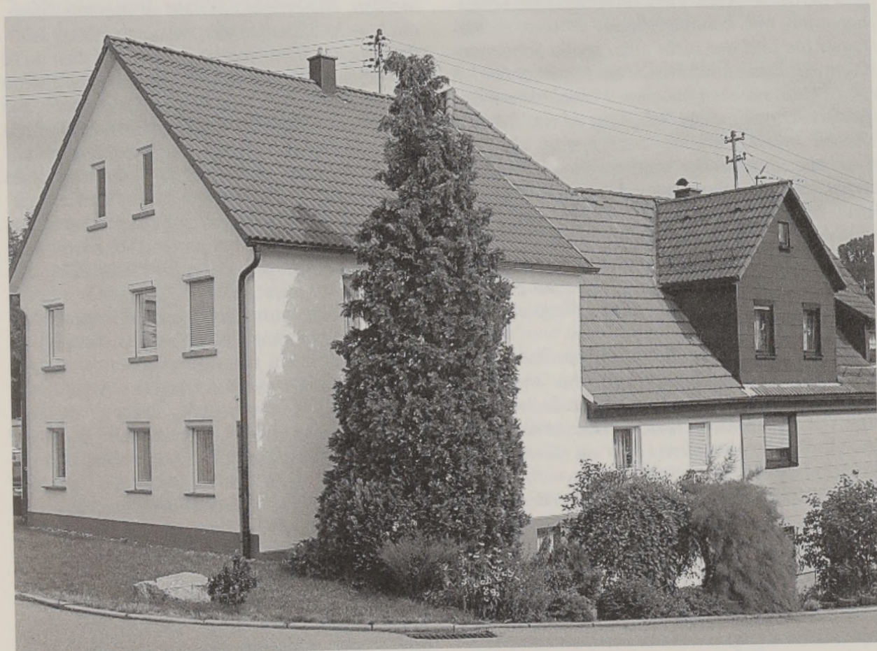
Das ehemalige Schlichenmaiersche Anwesen in Unterbrüden im heutigen Zustand.
