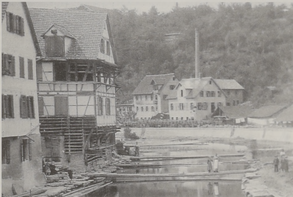
Abb. 30: Hinter den Gebäuden des Rotgerbers Georg Baumann sind Teile der Lederfabrik Gottlob Wühler und dessen Schornstein zu sehen (Aufnahme von 1904).
