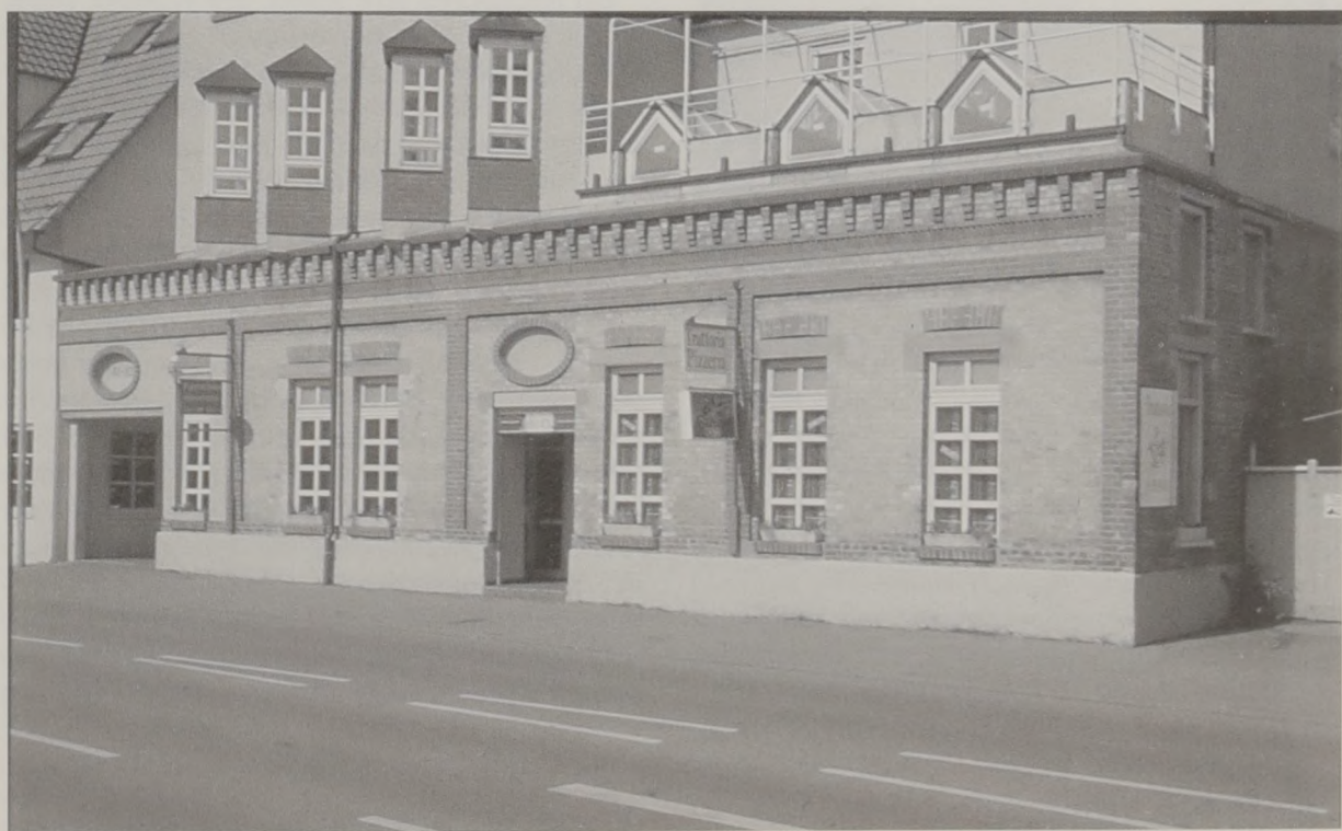
Abb. 25: Nachdem die Aufstockung des Shedbaus 1898 gescheitert war, wurde sie rund 100 Jahre später zu Wohnzwecken nachgeholt (Aufnahme von 1995).
