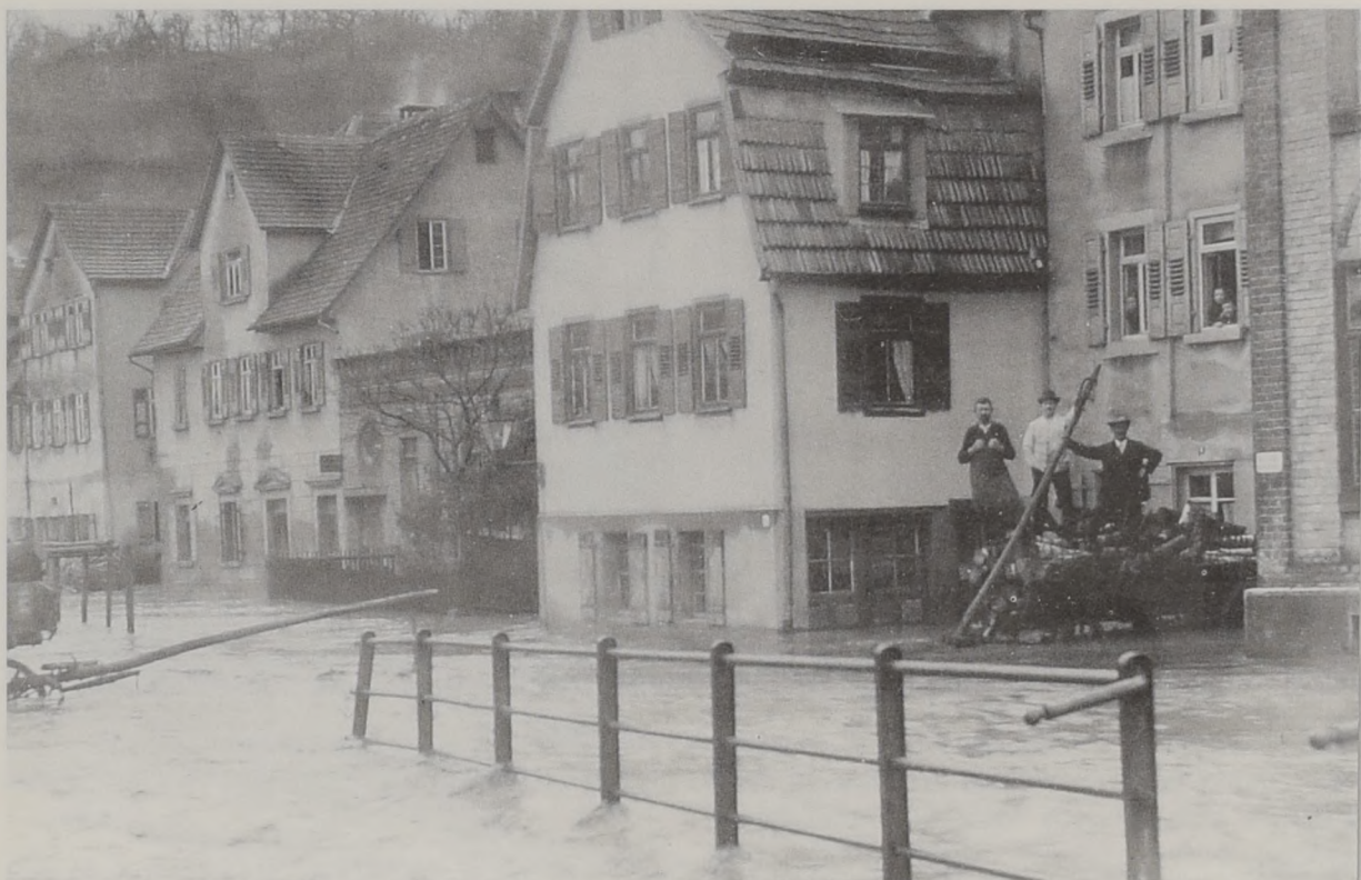
Abb. 24: Überschwemmung in der Badstraße am 6. März 1914. Hinter dem Giebel des Gebäudes Nr. 8 ist ein Teil des Shedbaus Nr. 14 sowie das Wohn- und Gerbereigebäude Nr. 16 von Ernst Breuninger zu sehen.
