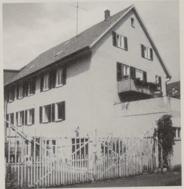
Abb. 1: Die vom Tuchscherer Wilhelm Friedrich 1871 erbaute und später verbreiterte dreigeschossige Walke, Gartenstraße 154. Walkeinrichtungen sind nicht mehr vorhanden (Aufnahme von 2003).
