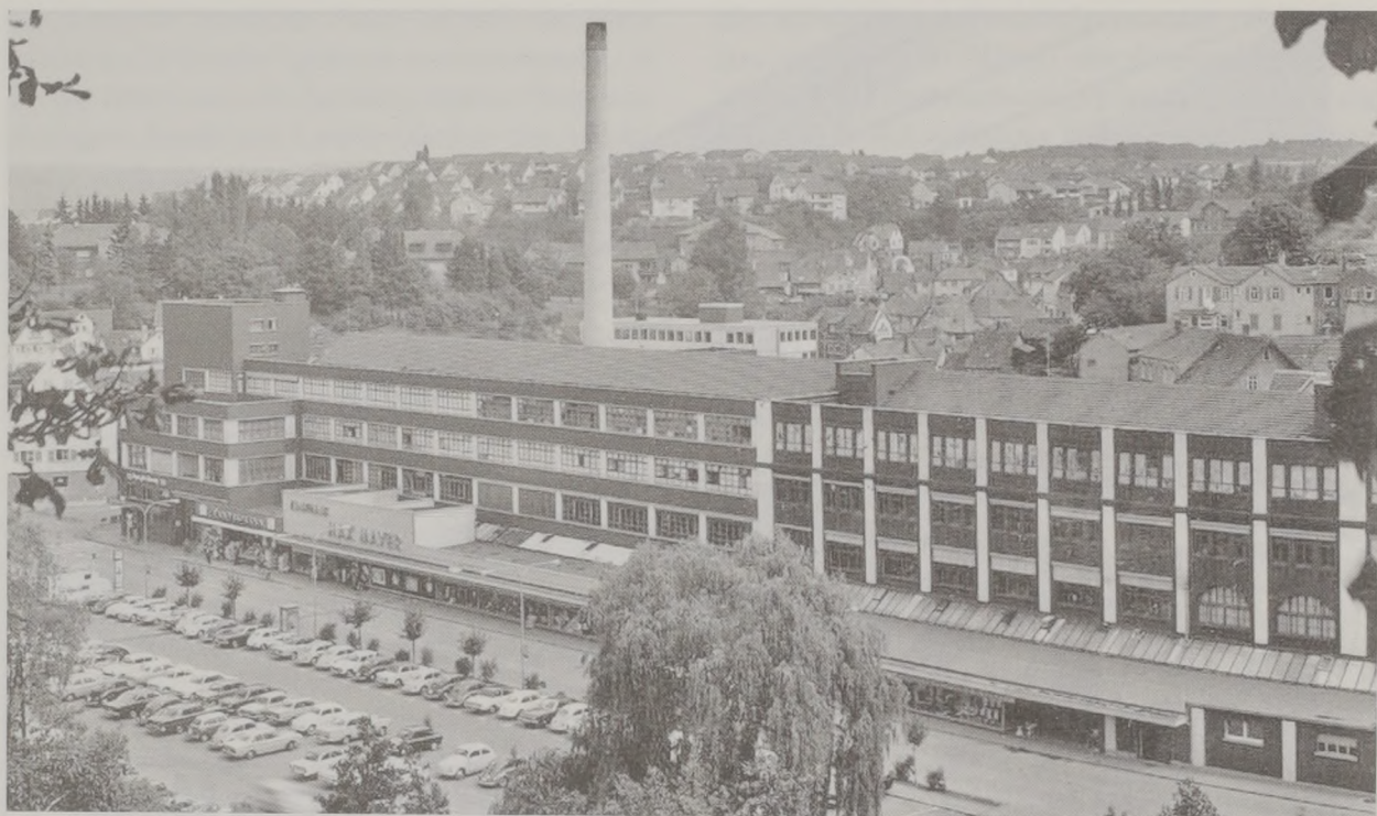
Blick vom Freithof auf das Kaufhaus Max Mayer in der ehemaligen Lederfabrik Schweizer.
