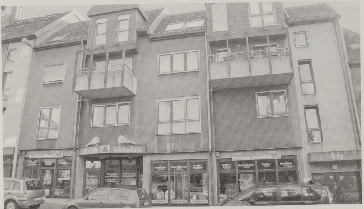
Das moderne Ladengeschäft der Backnanger Schlüsselhilfe in der Sulzbacher Straße 48-50.
