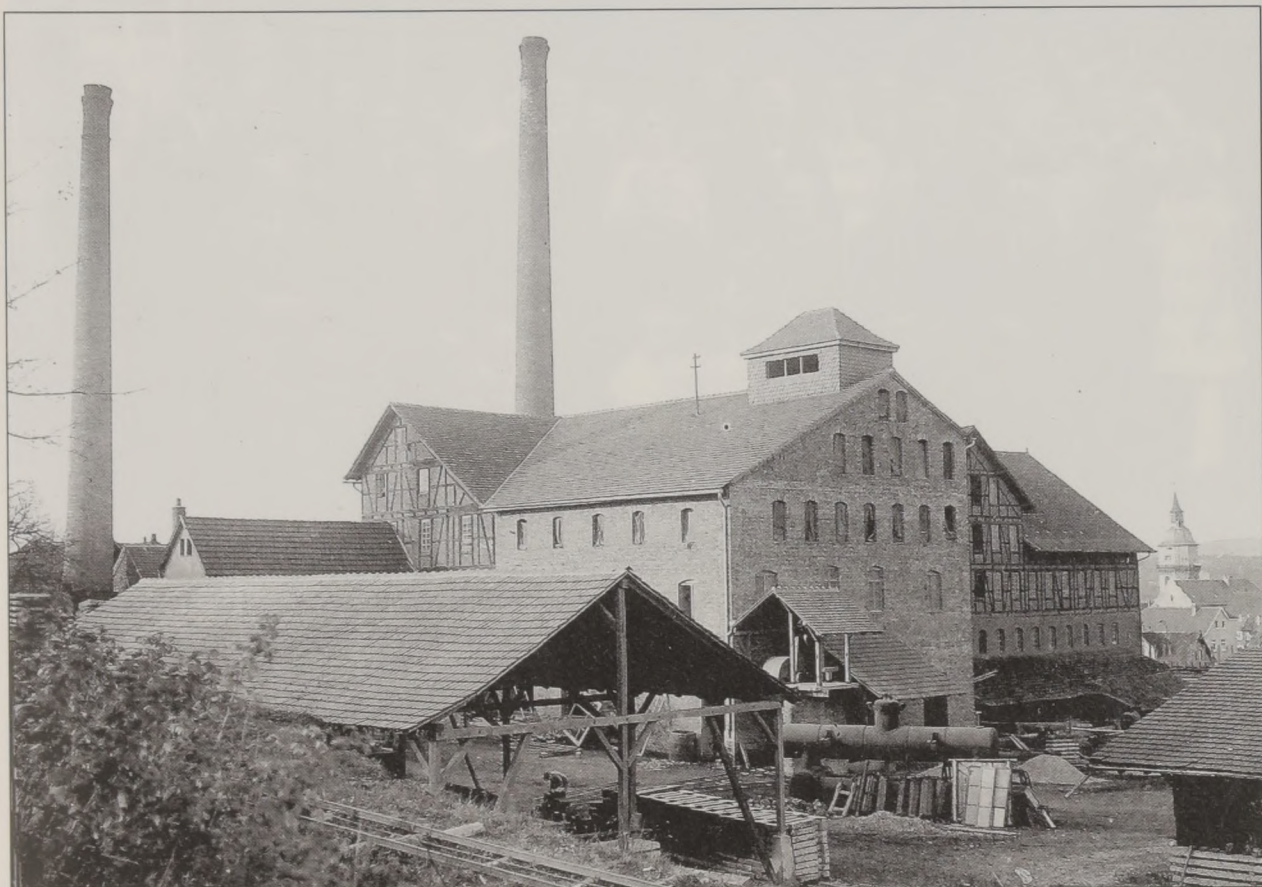
Die Ziegelei Ende 1926. In der Mitte das neu erbaute Ziegeleigebäude mit Kollergang.
