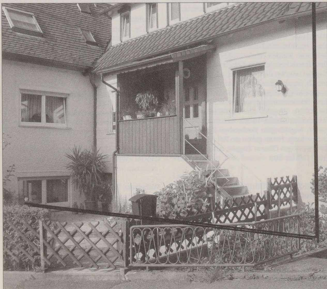
Blick von Westen auf die heutigen Gebäude Heiningen Weg 1/2 und 3/1, unter deren Putz die mittelalterliche Obere Ziegelei steht.
