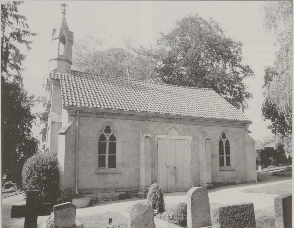
Seitenansicht der Friedhofkapelle mit dem nachträglich eingebauten Tor.
