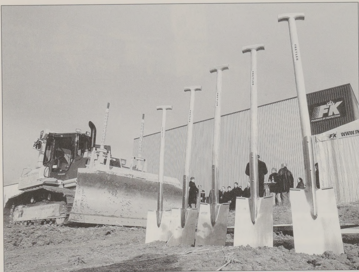
Spatenstich für ein Projekt der Superlative: Neues Logistikzentrum der Firma FK Automotive.
