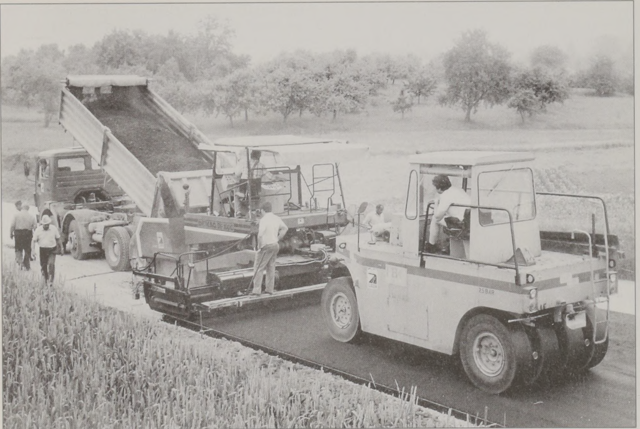
Straßenbau als „Lieblingsbeschäftigung“ der Fa. Gläser (hier: Belagsarbeiten auf der Kreisstraße 1828 zwischen Allmersbach am Weinberg und Kleinaspach im Jahr 1987).
