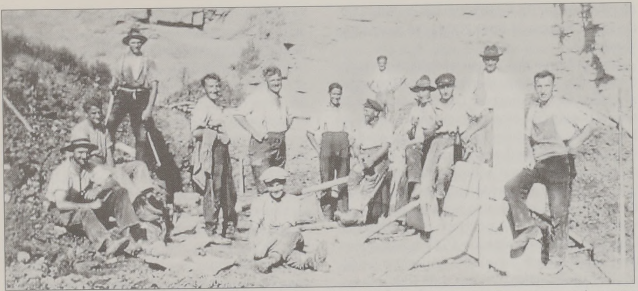
Arbeiten am ersten Fundament für ein Schottersilo im Steinbruch Zwingelhausen im Jahr 1933 (5. v. l. stehend: Lukas Gläser, Enkel des Firmengründers).
