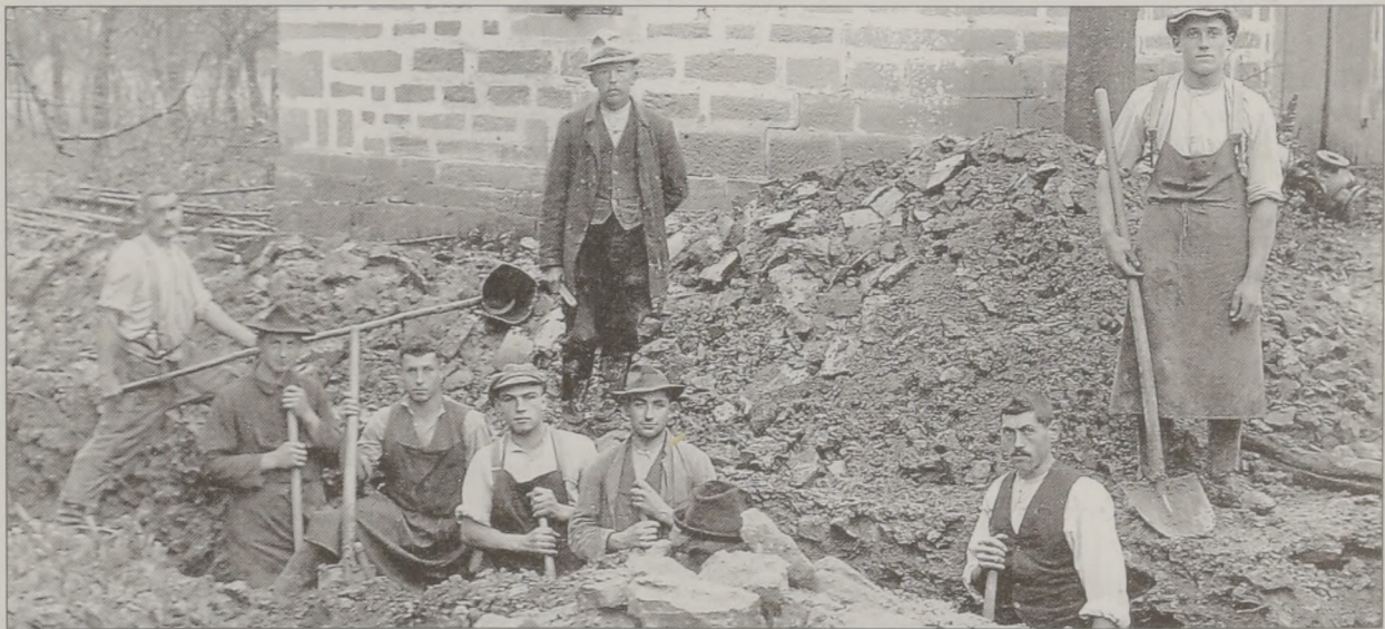
Der Tiefbau gehört von jeher zur Firmenstrategie (hier: Wasserleitungsbau im Frühmesshof um 1930).
