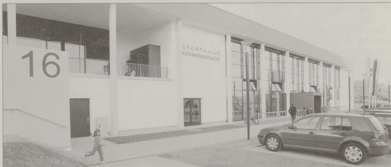
Lange gewünscht, endlich Realität: Die fertiggestellte Sporthalle Katharinenplaisir.
