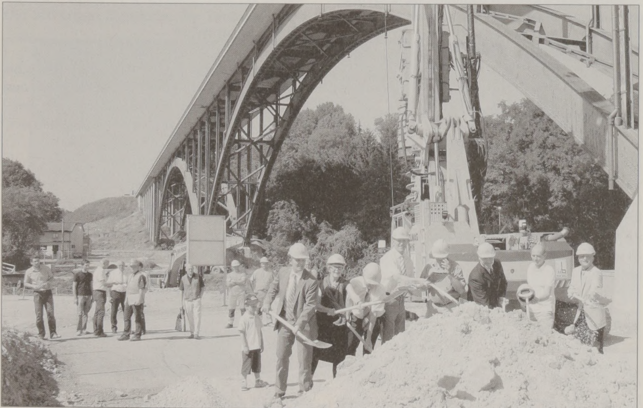
Startschuss zum Bau des neuen Murratal-Viadukts.
