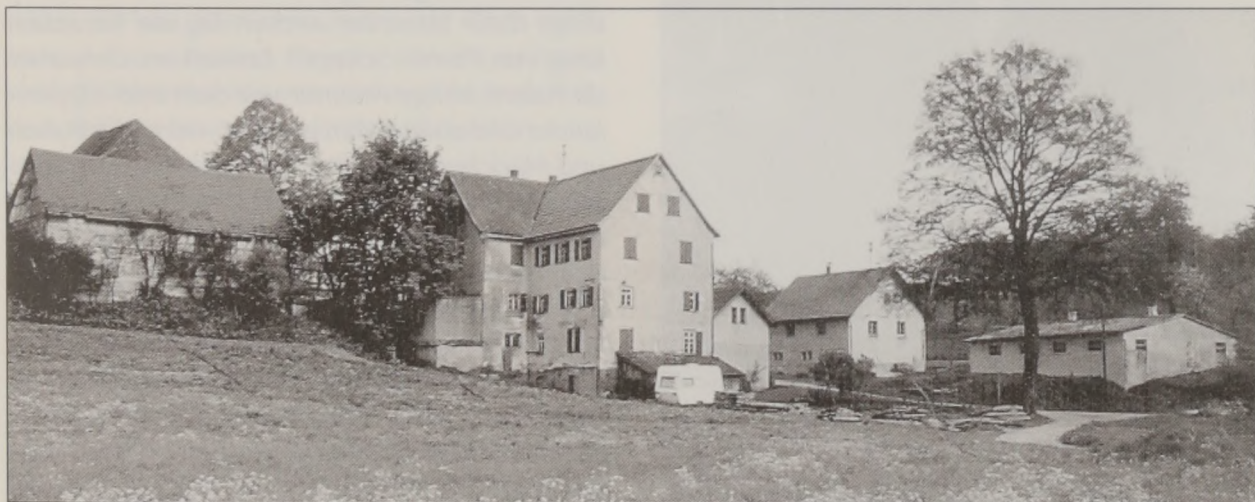
Die Talmühle wurde ursprünglich als Ölmühle gebaut, später dann als Getreidemühle genutzt.
