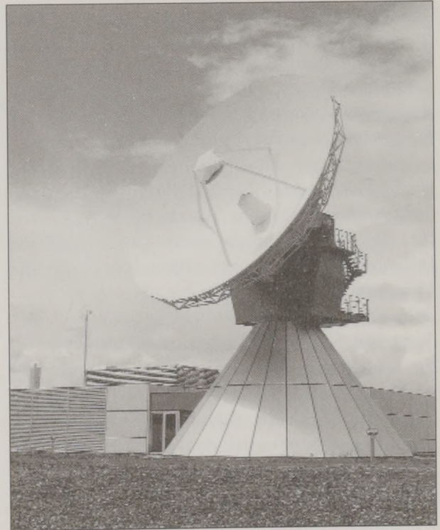
Erdefunkstelle für das Satellitenprojekt „Symphonie“ in Raisting am Ammersee mit der 15,5-m-Antenne.
