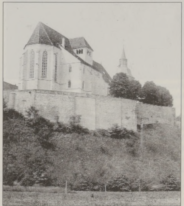
Blick von der „unteren Tauswiese“ auf den Burgberg mit dem Anfang des 16. Jh. an die Stiftskirche angebauten Gotischen Chor (Aufnahme um 1900).
