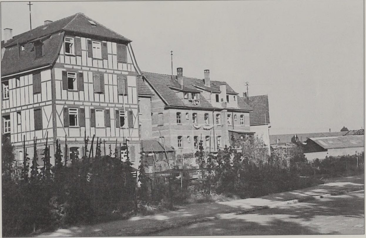
Gebäude Gartenstraße 40 bis 52. Am rechten Bildrand ist ein Teil des Rohwarenschuppens der Lederfabrik Louis Schweizer (Nr. 60) zu sehen, der 1937 erstellt wurde.
