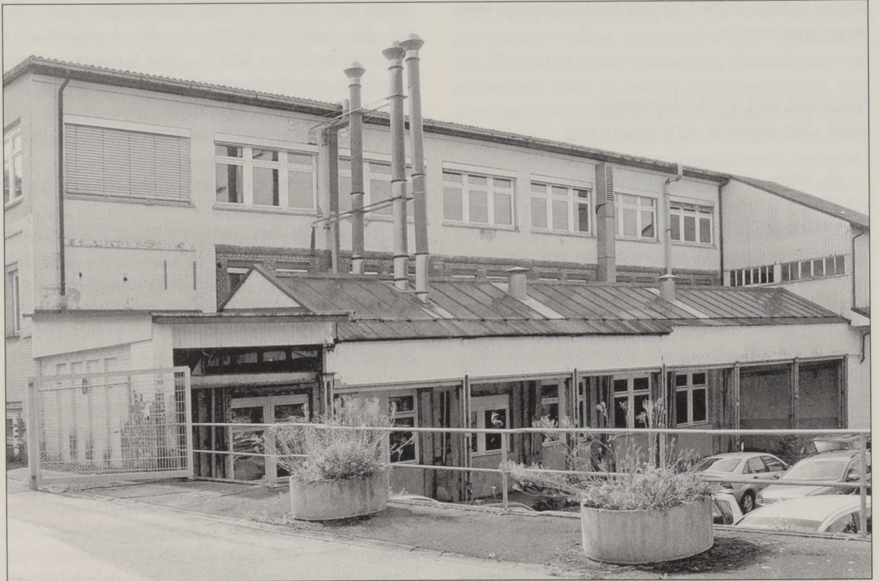
Im Gebäude Wilhelmstraße 43 war die VSAT-Gruppe nach ihrer Ausgliederung aus der Raumfahrt-Abteilung untergebracht.
