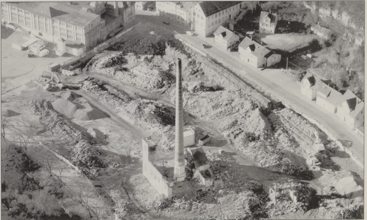
Der letzte Schornstein in der Oberen Walke kurz vor seiner Sprengung.
