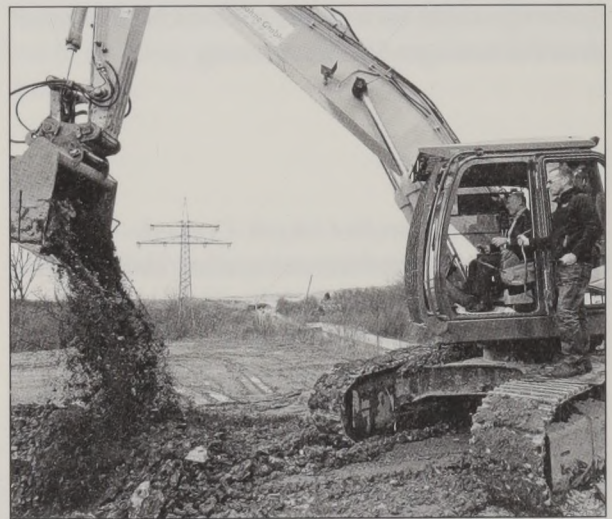
Verkehrsminister Winfried Hermann beim Baggerbiss zum Baubeginn des B-14-Anschlusses Backnang-Mitte.
