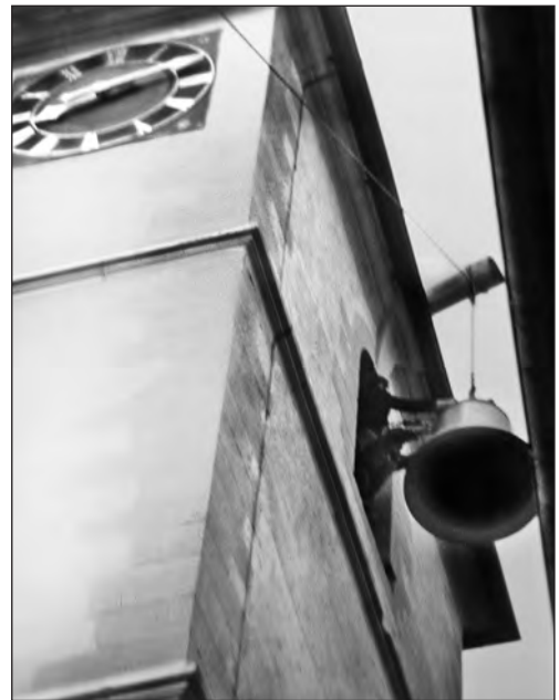
Am 11. November 1968 wurde die Glocke auf den Turm gezogen. Der Glockensachverständige stellte fest: „Ein hervorragendes Meisterstück!“
