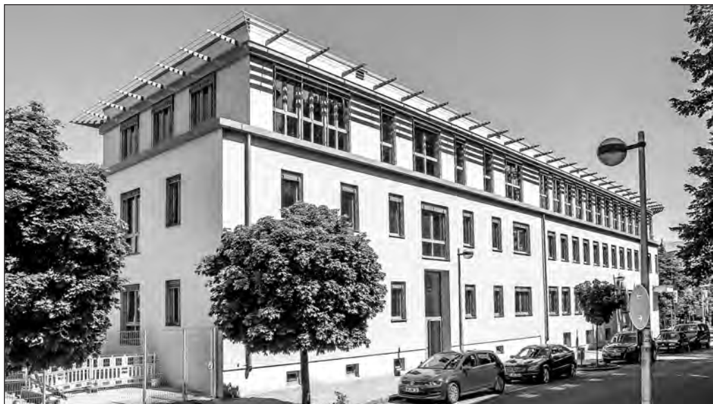
Das nach einem Umbau neu eröffnete Bildungshaus in der Bahnhofstraße.
