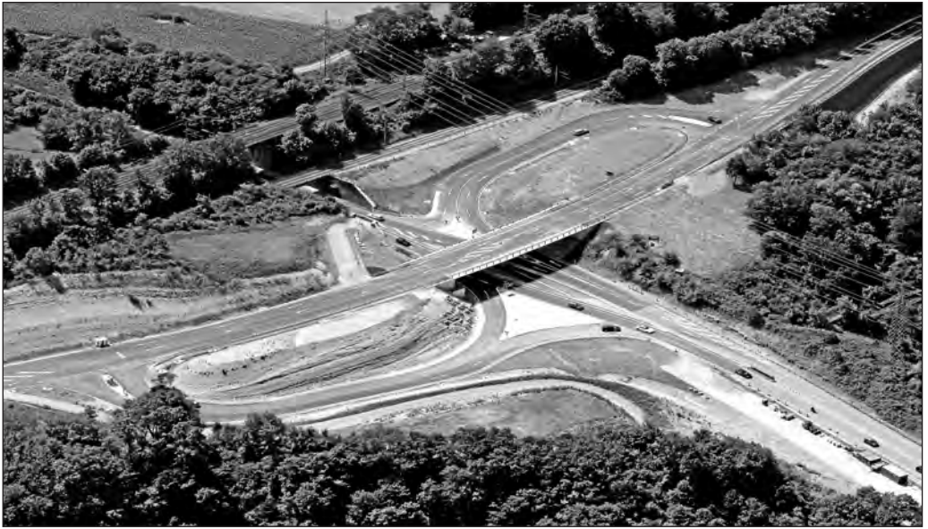
Die neue B-14-Anschlussstelle Backnang-Mitte aus der Vogelperspektive.
