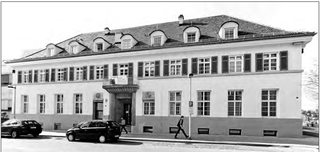
Nach umfangreichen Umbaumaßnahmen wird die „Alte Post“ als Wohn- und Begegnungszentrum neu eröffnet.
