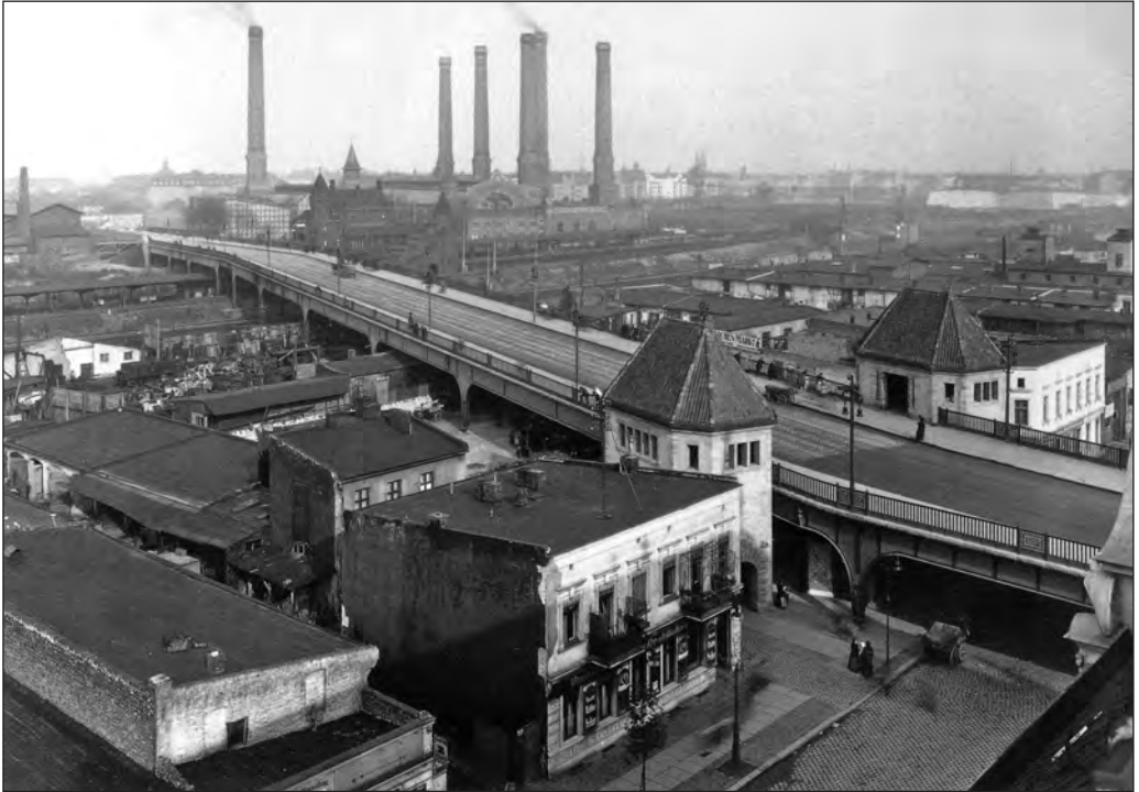
Blick auf die Pulitzbrücke in Berlin-Moabit im Jahr 1912. Hier befand sich einer der wichtigsten Güterbahnhöfe Berlins.
