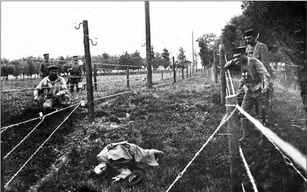
Ein Teil des auf rund 300 km entlang der belgisch-niederländischen Grenze gespannten „Grenzhochspannungshindernisses“.
