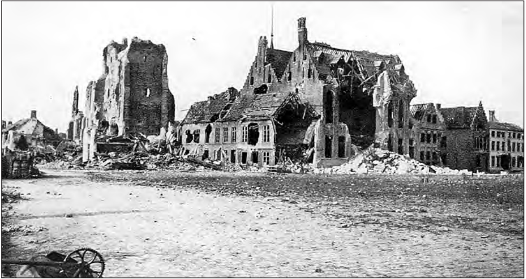
Von dem im unmittelbaren Frontbereich liegenden belgischen Städtchen Dixmuide blieben nur noch Trümmer übrig.
