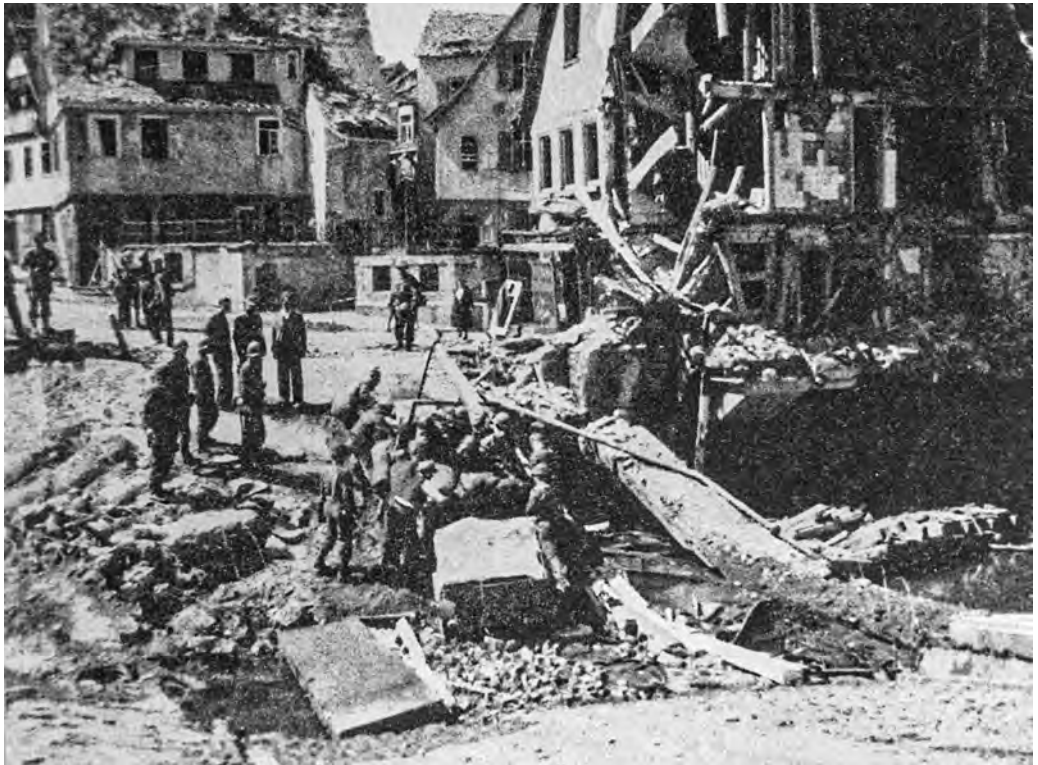
Die nur zusammengesackte Sulzbacher Brücke konnte schnell wieder notdürftig hergestellt werden.
