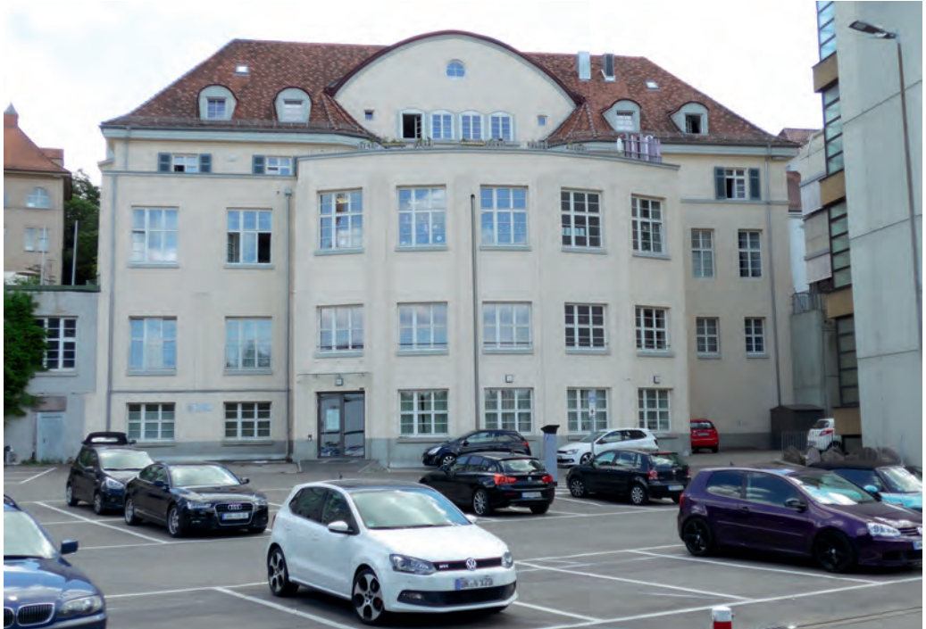
Die Rückseite des ehemaligen Postamtes Backnang im heutigen Zustand.
