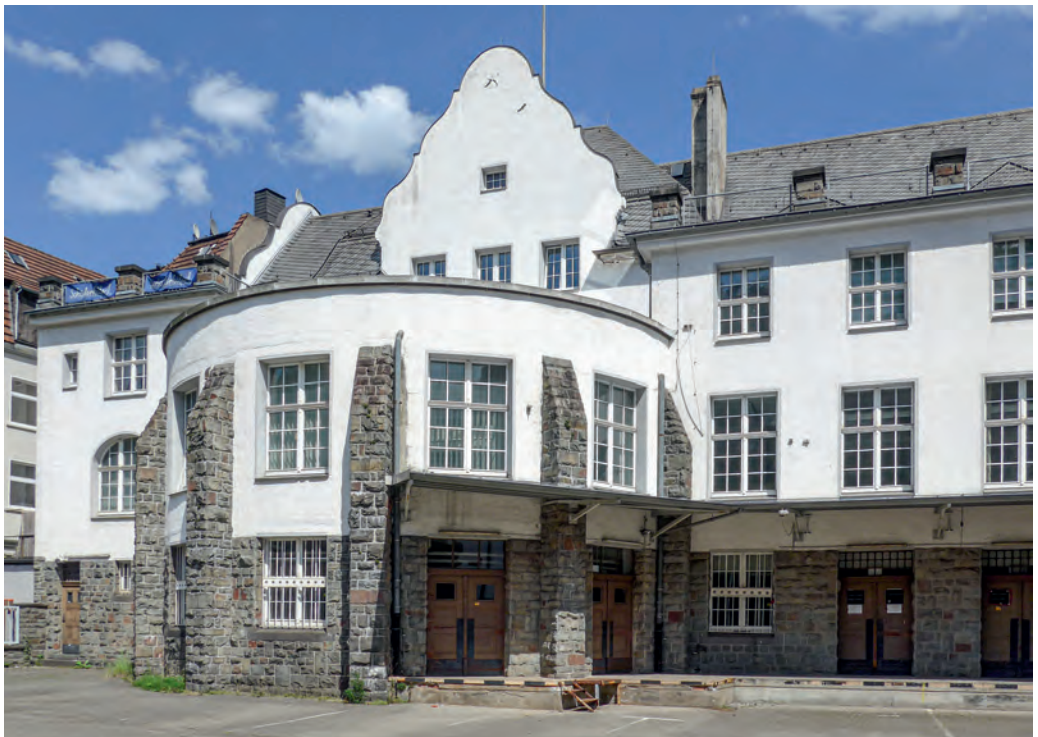
Das ehemalige Postamt in Altona: Rückseite mit Postbetriebsraum.
