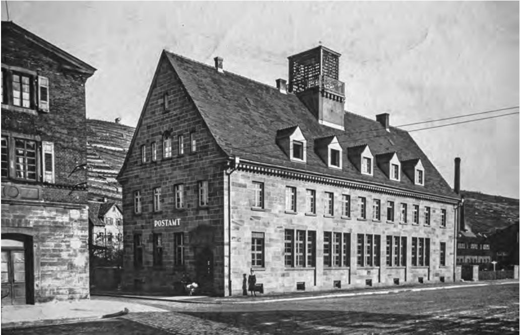
Das Postamt in Obertürkheim wurde zur selben Zeit wie das in Backnang erbaut und ebenfalls von Martin Mayer geplant.
