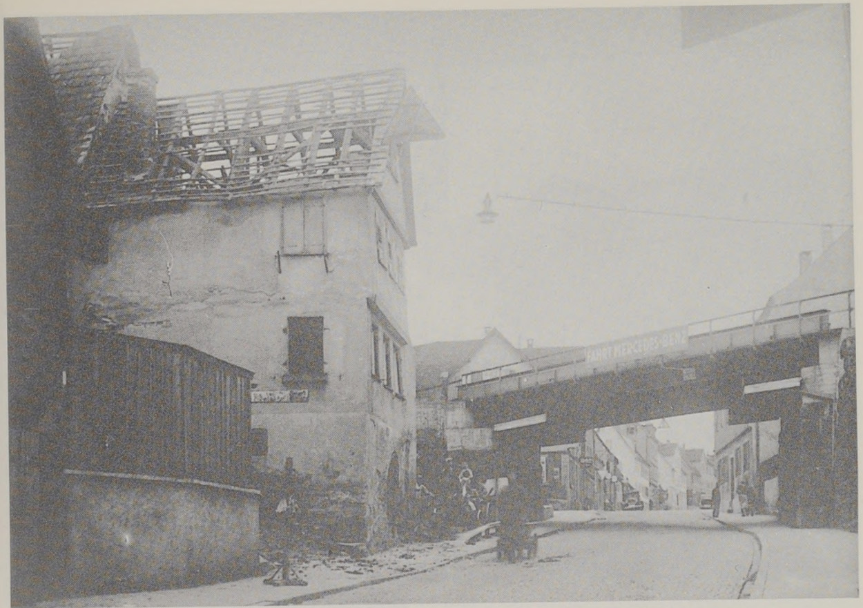
Der Abbruch des städtischen Dreifamilienhauses Stuttgarter Straße 31 erfolgte 1934/35.
