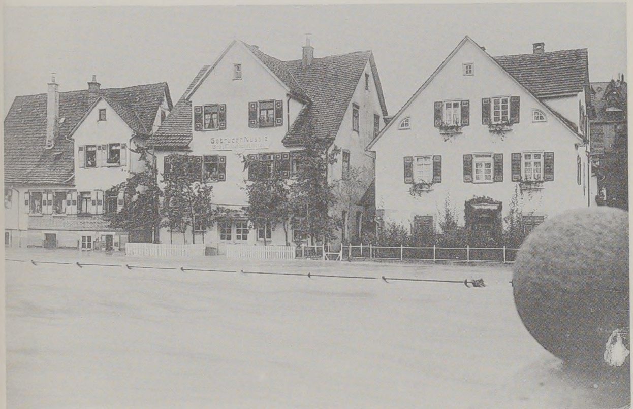
Unterhalb der Aspacher Brücke am Kalten Wasser.
