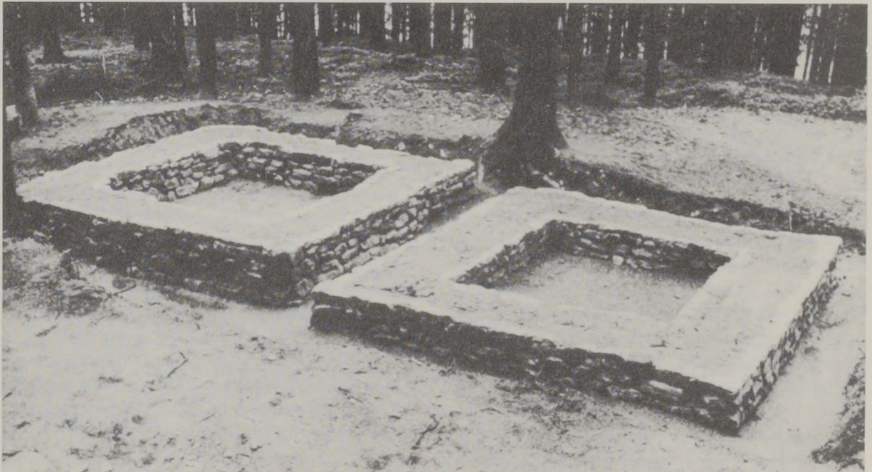
Fundamente der beiden Wachtürme von Murrhardt–Heidenbühl (Zustand vor 1969).
