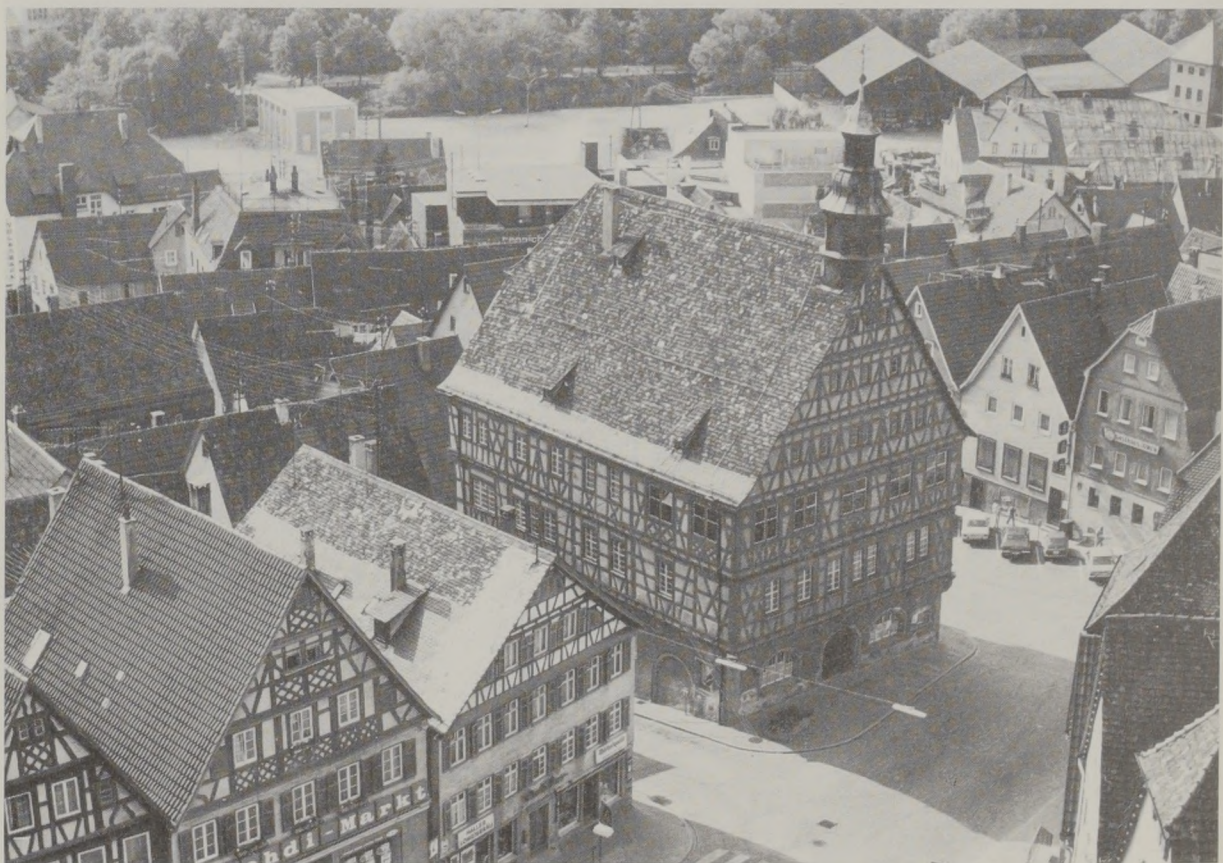
Die vom Stadtturm gemachte Aufnahme des Backnanger Rathauses zeigt deutlich die enorme Bau- masse des stolzen Fachwerkgebäudes.
