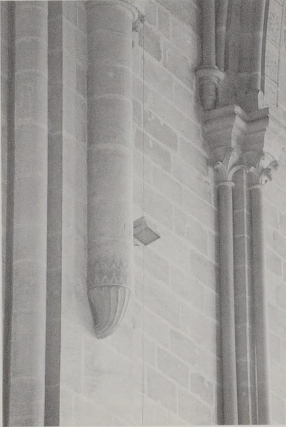
Abb. 33: Dienstkonsole des Peterschors in Bamberg, Detailaufnahme.
