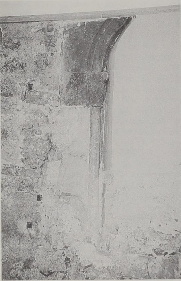
Abb. 18: Turmschulhaus. Rundbogenfragment in der Erdgeschoß-Ostwand des nördlichen Schulzimmers.
