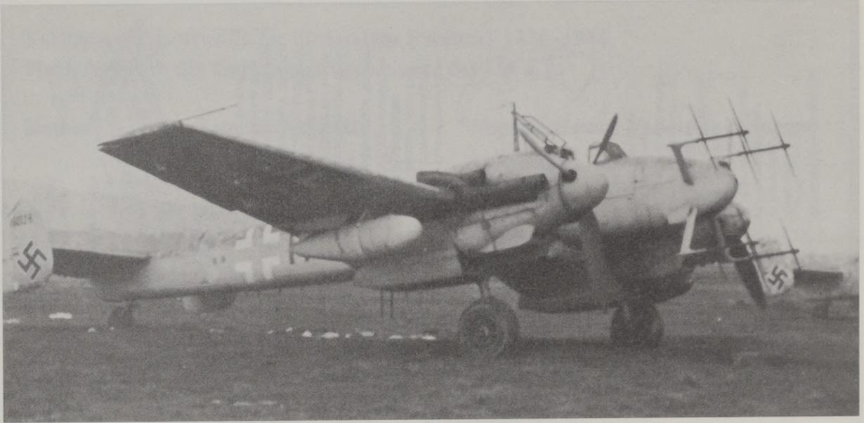
Abb. 5: Eine voll intakte Messerschmitt Bf 110 G-4 der 9./NJG 1, die im April 1945 von US-Truppen in Fritzlar gefunden wurde.
