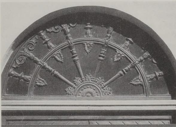
Abb. 29: Torbogen von Ferdinand Thumms Eingang zum Eisen-Magazin mit der noch vorhandenen gußeisernen Halb-Rosette, einer Ware, die auch in seinem Laden angeboten wurde.
