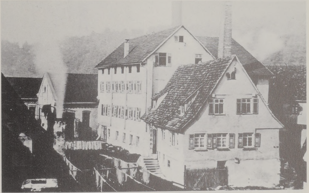
Abb. 20: Die Lederfabrik Carl Kaess nach der Erweiterung von 1891. Hinter dem dreieinhalbgeschossigen Gerbereigebäude ist ein Teil des neuen Kessel- und Maschinen-Hauses und der große Grubenbau zu sehen. Der kleine Kamin hinter dem Wohnhaus gehört noch zum Kesselhaus von 1873.
