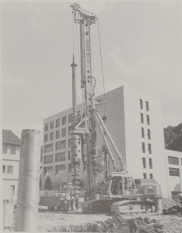
Die geologische Situation erfordert besondere Sicherheitsmaßnahmen für die Aushubarbeiten der neuen Fertigungsstätte für Satellitensysteme in der Gerberstraße. Bohrer schaffen die Voraussetzung für eine wasserdichte Wanne.
