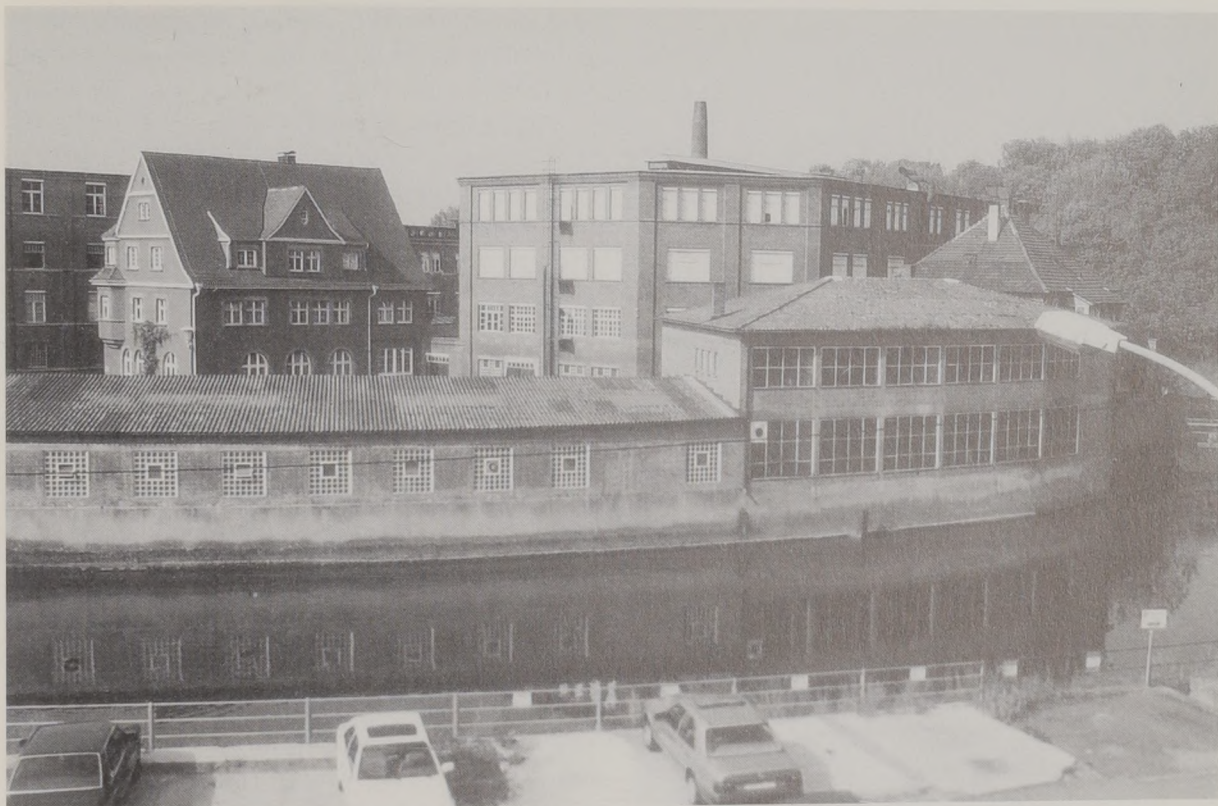
Abb. 33: Die geschlossene Murrseite der Lederfabrik Carl Kaess um 1985.
