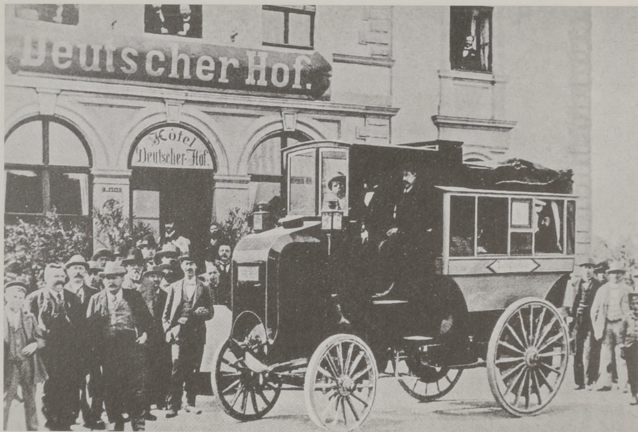
Umgebaute Postkutsche im Jahr 1898.
