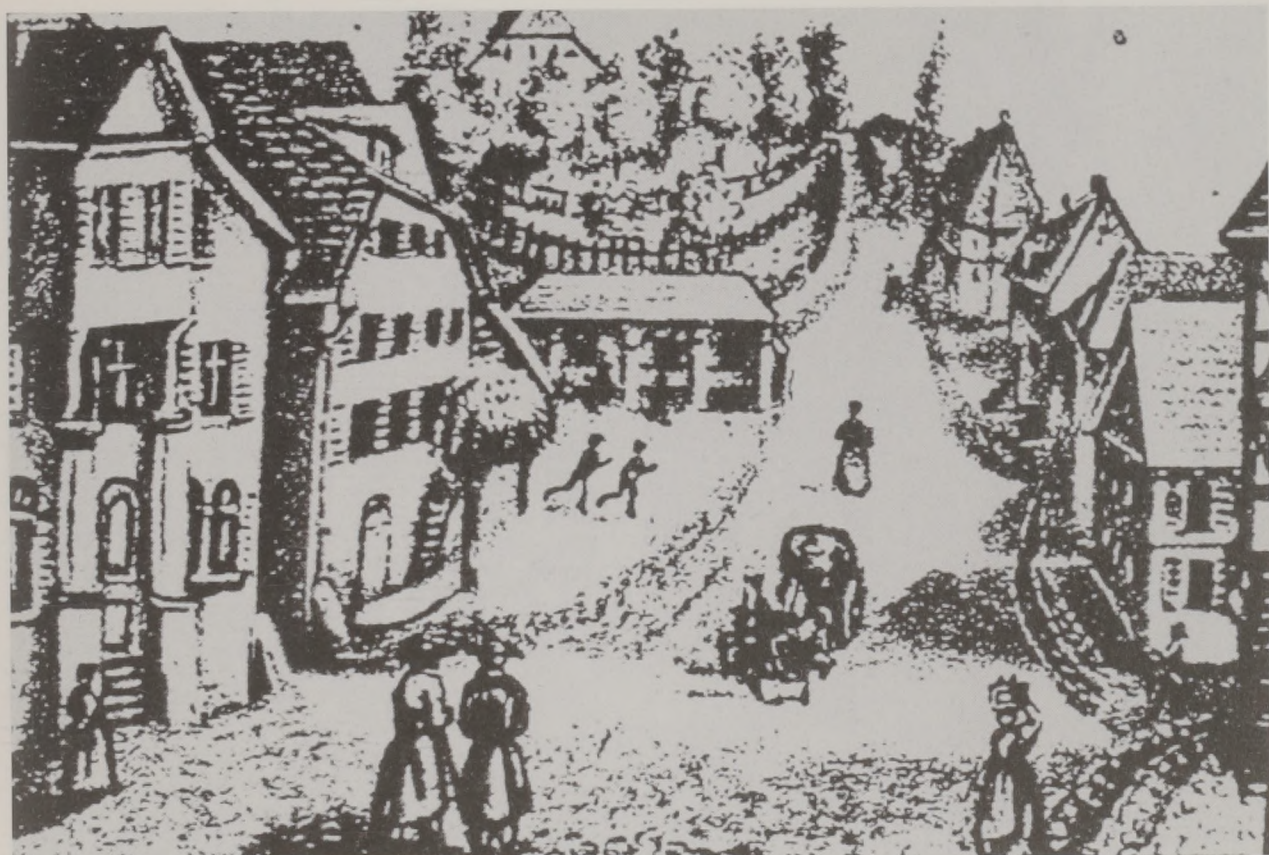
Abb. 11: Backnanger Marktplatz – bereits ohne Marktbrunnen.
