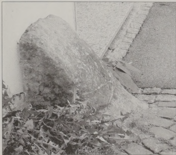
Sollte das Gebäude vor Beschädigungen schützen: Radabweiser in Backnang.
