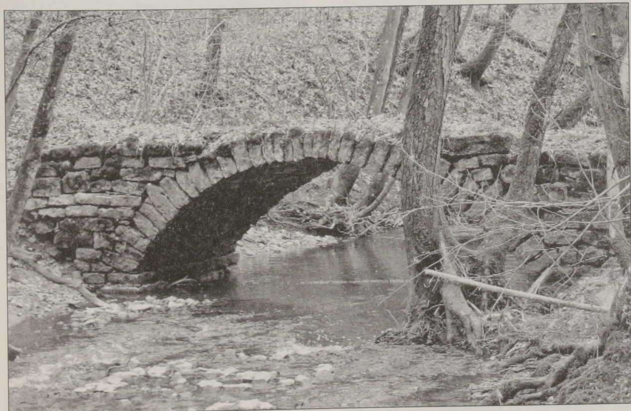
Die Backnanger-Weg-Brücke im Wüstenbachtal.
