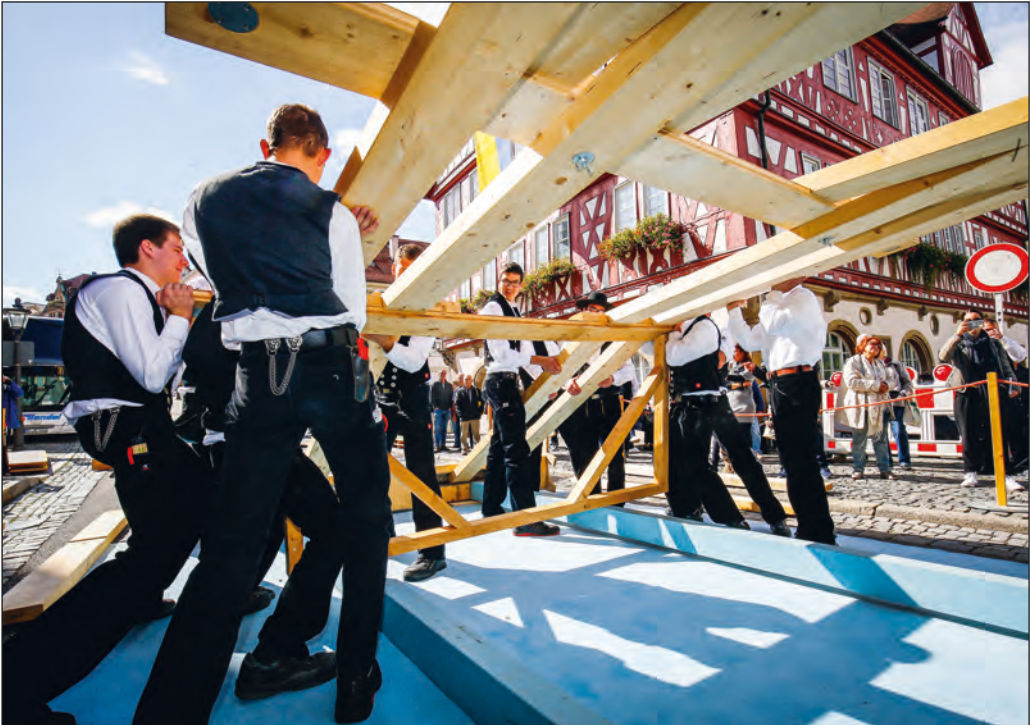
Aufbau einer Holzbrücke vor dem Rathaus beim Landesholzbautag.
