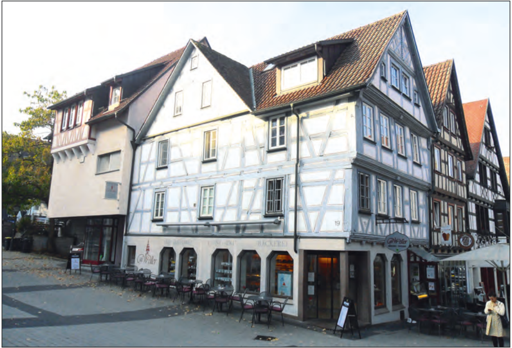
Bäckerei, Konditorei und Café Weller in der Schillerstraße 19 im heutigen Zustand.
