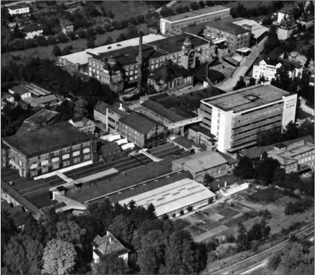
Die Luftaufnahme aus den 1960er-Jahren zeigt, wie eng bebaut das Werksareal der Spinnerei Adolff inzwischen war.
