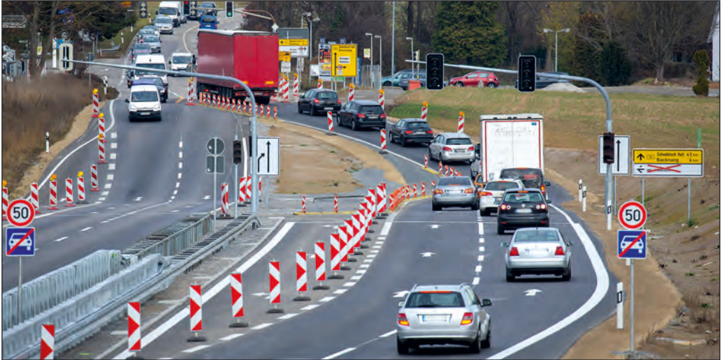
Nach rund zweijähriger Bauzeit wird der vierspurige Abschnitt der B 14 von Nellmersbach nach Backnang-Waldrems für den Verkehr freigegeben.
