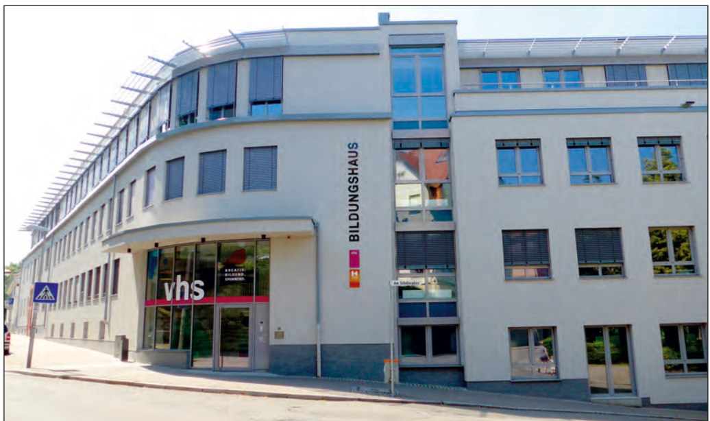
Der Komplex nach dem Umbau zum Bildungshaus. Man erkennt noch die markante Rundung der ehemaligen Oberamtssparkasse.
