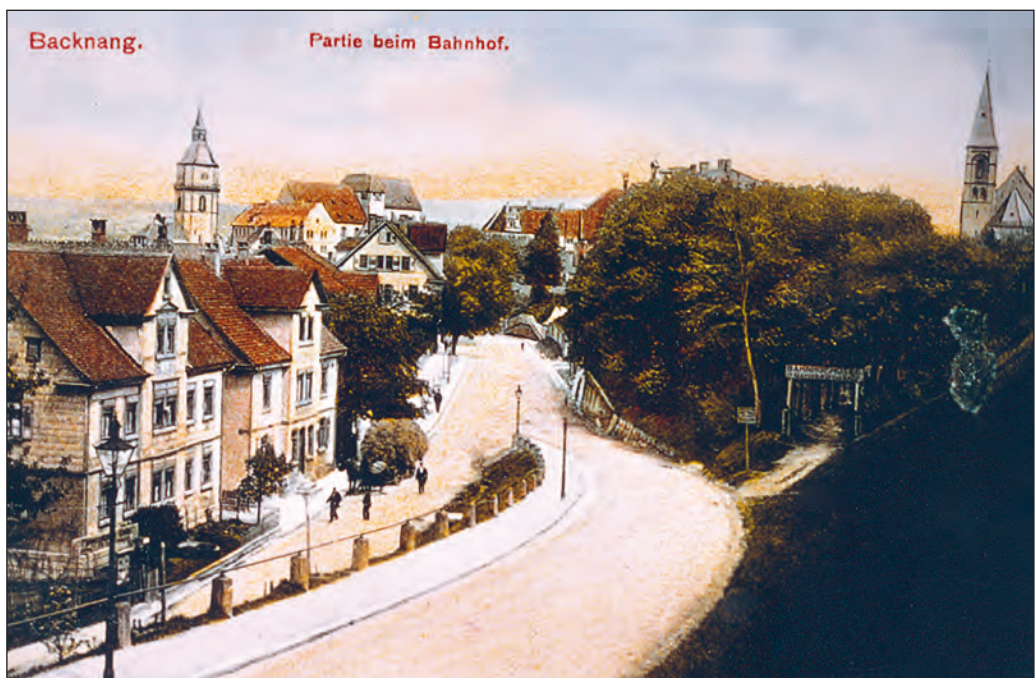
Blick vom Bahnhof auf die Bahnhofstraße mit dem Eingang zum Biergarten des Bahnhofhotels.
