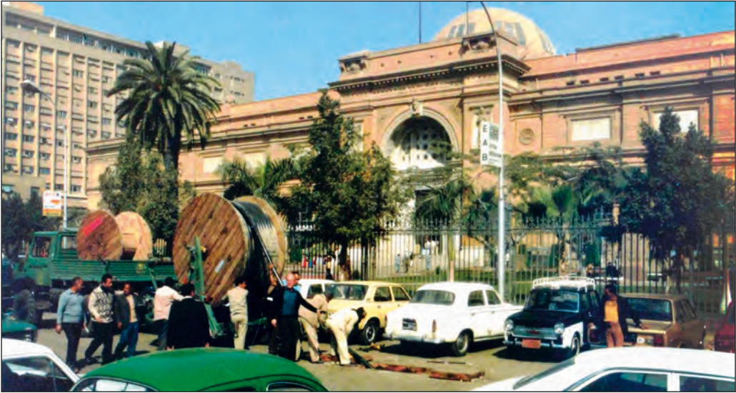
Verlegung eines Fernmeldekabels vor dem Ägyptischen Museum in Kairo.
