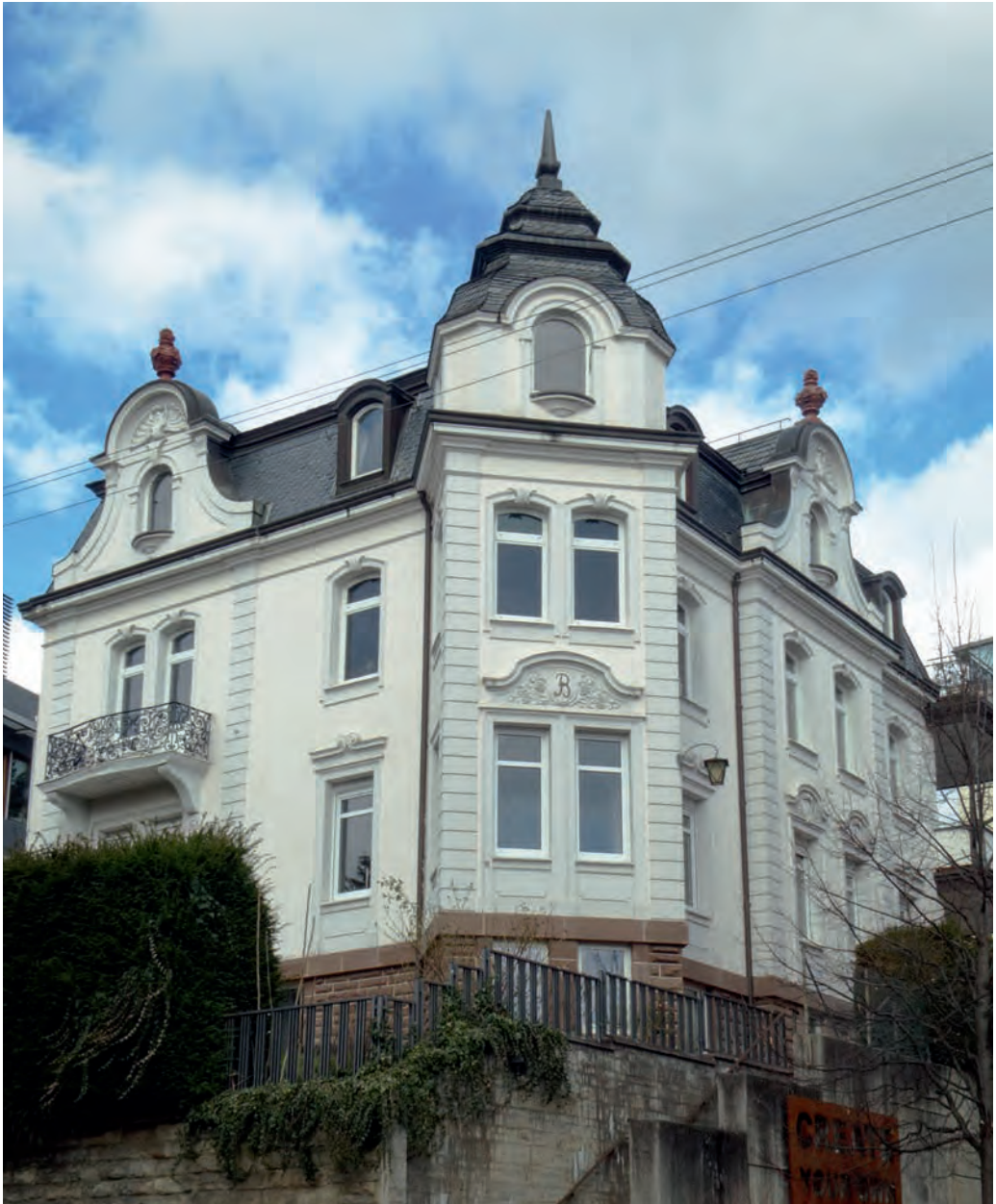
Das Breuninger-Wohnhaus im Herdweg, Stuttgart. Das Gebäude wurde zwischen 1888 und 1894 von Ludwig Eisenlohr und Carl Weigle im Neobarockstil erbaut.
