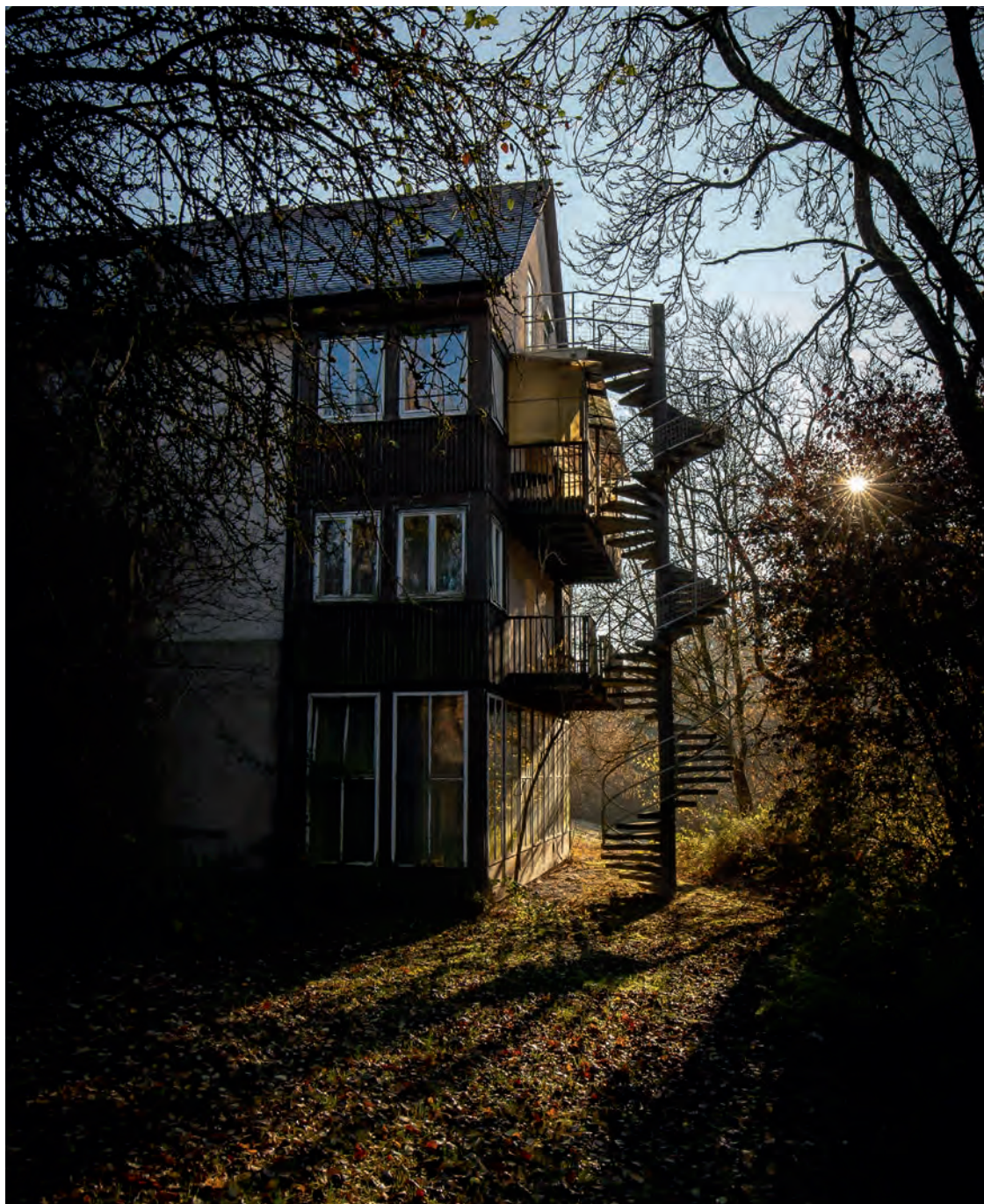
Auch auf dem Gelände des Alten- und Pflegeheims Staigacker fand sich ein verlassenes Gebäude, dessen Wendeltreppe sich geradezu idyllisch vor dem Sonnenuntergang zeigt.
