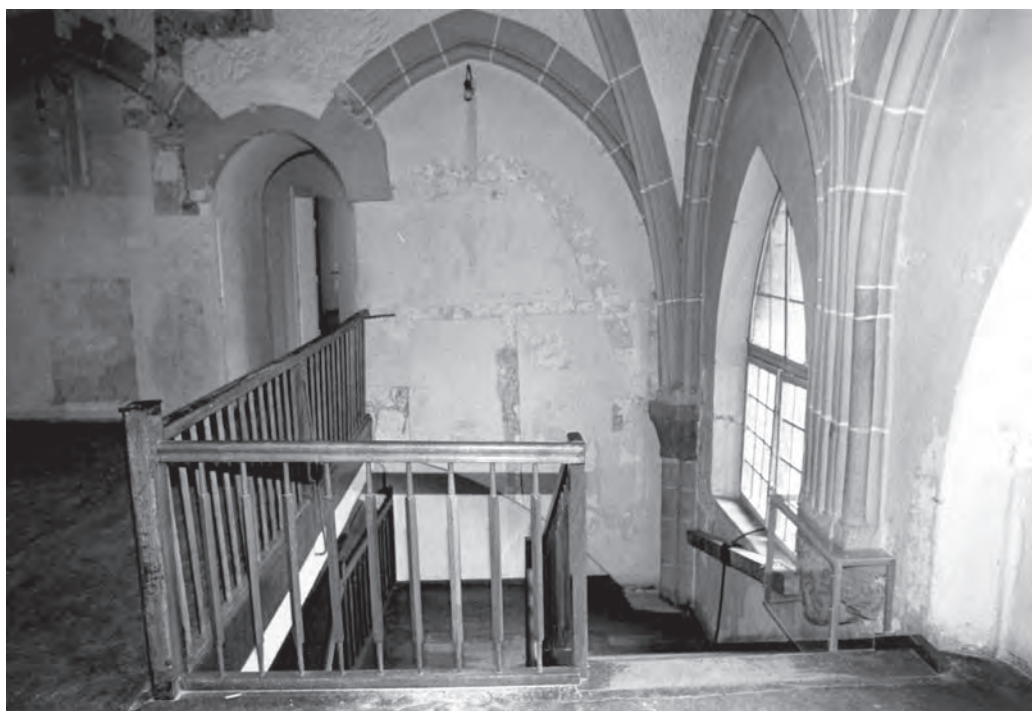
Blick in den gotischen Chor vor der Sanierung (Aufnahme von 1997).
