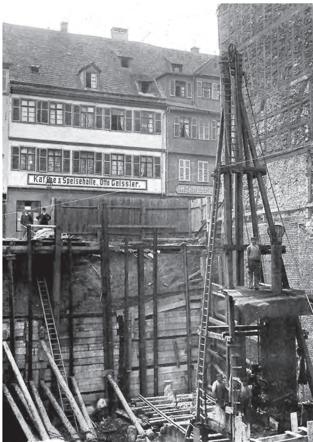
Die Baustelle zur Erweiterung der Breuninger-Gebäude an der Becherstraße (heute Marktstraße).
