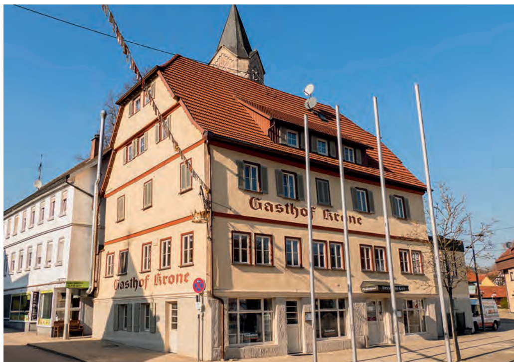
Dominiert noch heute den Sulzbacher Marktplatz: Der Gasthof „Krone“ an der Ecke Haller und Backnanger Straße.
