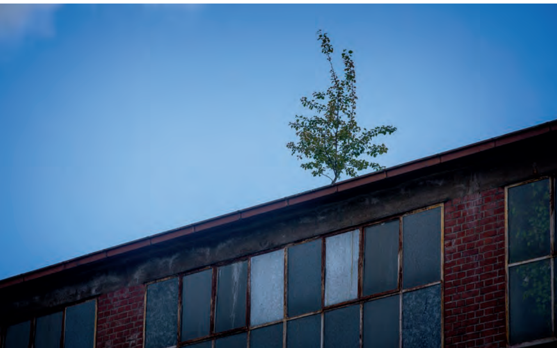
Zwei Außenimpressionen der ehemaligen Lederfabrik Hodum in der Eberhardstraße. Das schon lange leer stehende und mehr und mehr verfallende Fabrikgebäude an der Murr aus den 1930er-Jahren könnte im Zuge der IBA'27-Planungen eine Wiederauferstehung erleben.
