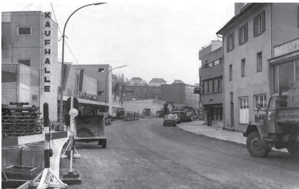
Verbreiterung der Grabenstraße im Jahr 1977 mit Blick auf die Kaufhalle und die Lederfabrik Carl Kaess im Hintergrund.
