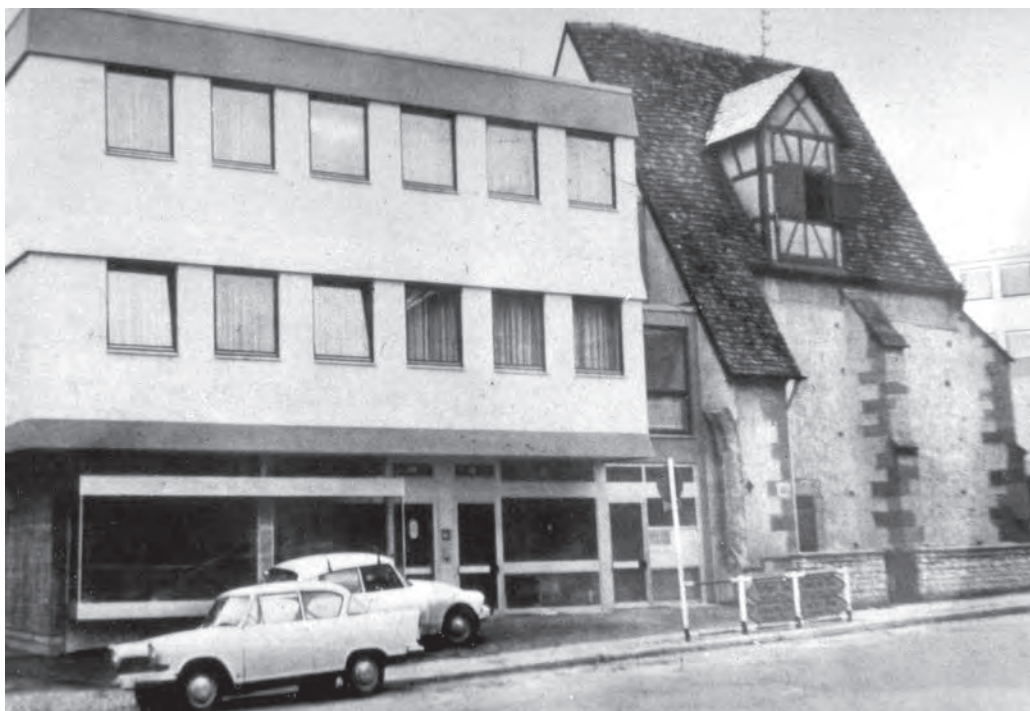
Ein besonders krasses Beispiel für die Verbindung von Historie und Moderne: Der an den Chor des historischen Totenkirchles angebaute Flachdachbau in Backnang (Aufnahme von 1970).
