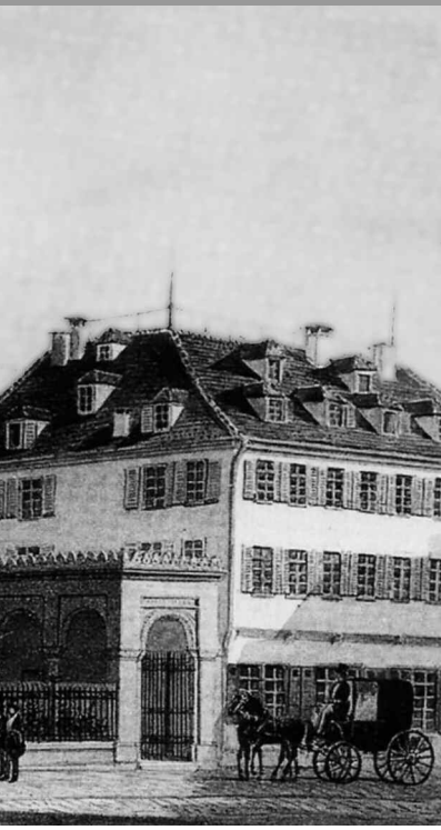
Die Stuttgarter Synagoge, 1859, Hospitalstraße 36
