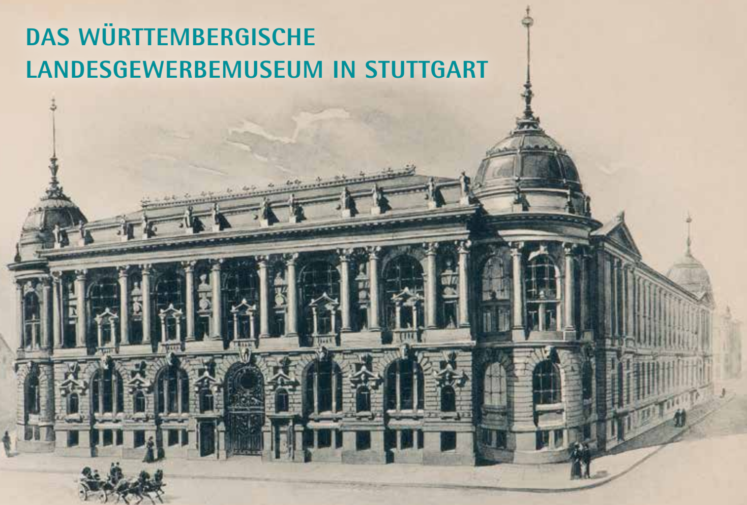
Die Fassade des Landesgewerbemuseums an der heutigen Willi-Bleicher-Straße, Zeichnung: Peter Schnorr, Lichtdruck: Hofkunstanstalt Martin Rommel & Co, 1896 (Aus der Festschrift zur Einweihung des Gebäudes, 1896. Foto: Hendrik Zwietasch)
